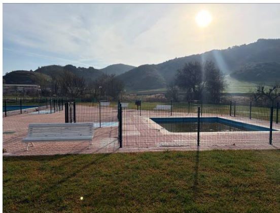
Foto 8: Piscina de chapoteo
