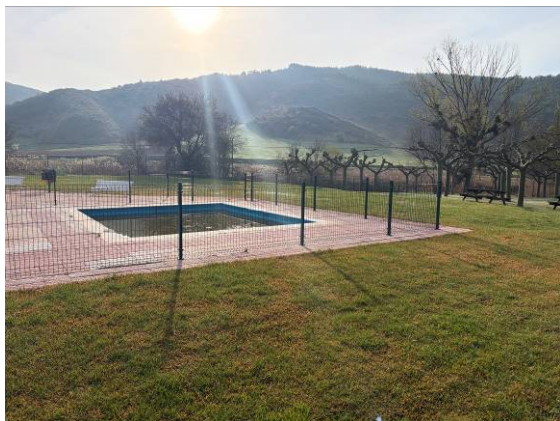
Foto 7: Piscina de chapoteo
