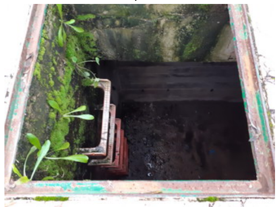
Foto 23: Acceso a sala de depuración
