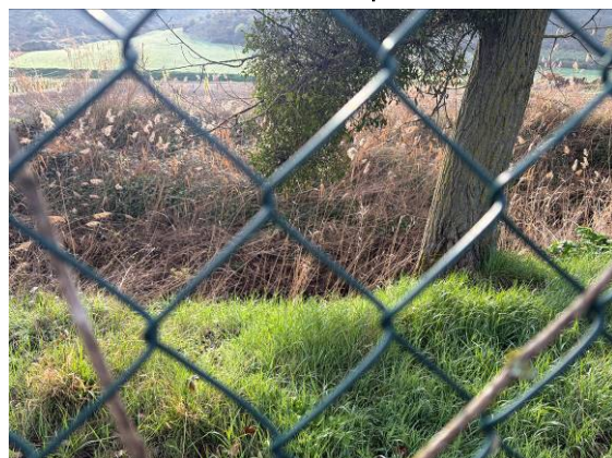
Foto 16: Punto de desagüe de piscinas
