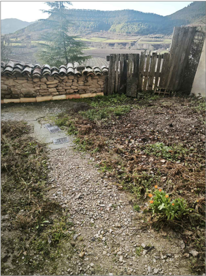
TRAMO 3 - NUEVO POZO (-1.80m)
