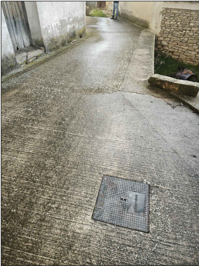
TRAMO 1 - CALLE LA PLAZA PAVIMENTO DE HORMIGÓN
