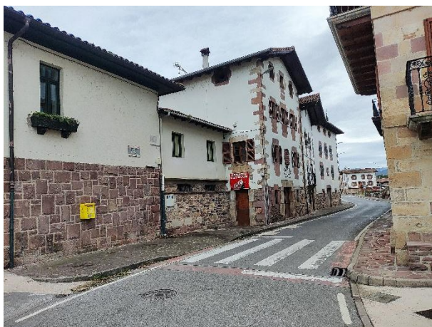
Fig. 2.2 Fachada norte y este
