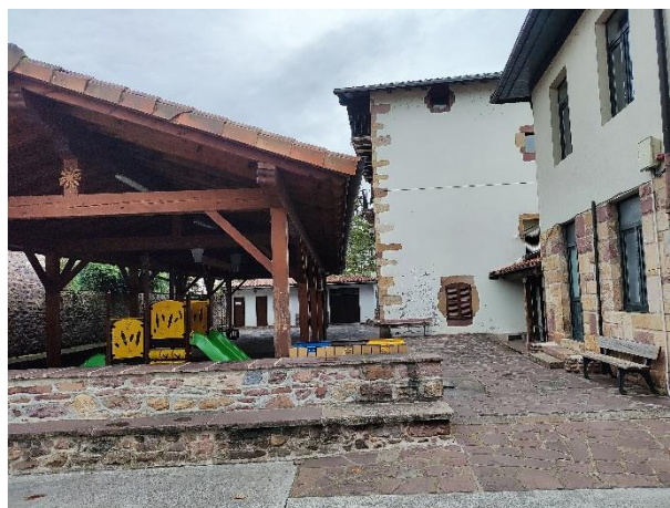
Fig. 2.3 Fachadas este y porche posterior
