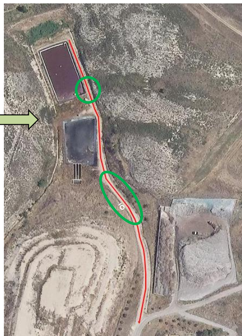
Acceso a las 2 balsas con camino en todo-uno
