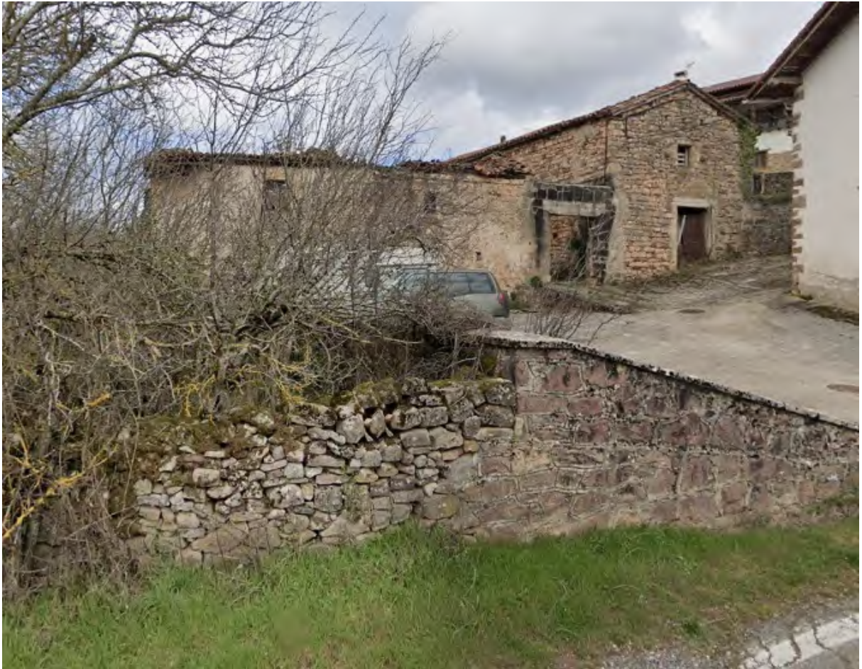
Vista del Palacio de Arrieta desde la carretera de acceso al pueblo. Fuente: Google Street View, año 2022 (antes del derrumbe parcial de la fachada del ala sur)
