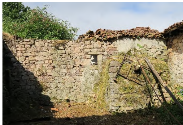
Volumen adosado al muro del patio del ala oeste
