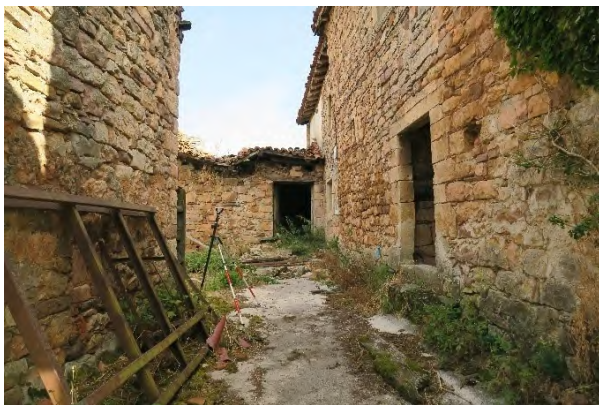
Accesos a las alas este y norte desde el patio.
