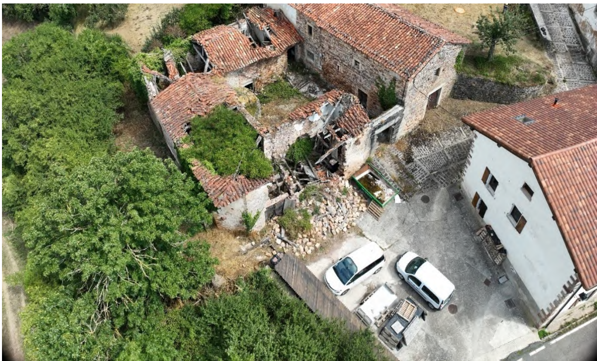
Vista del palacio, con la fachada principal en primer plano en la que se aprecia a diferencia de altura entre el volumen más alto del ala este y el volumen más bajo de las otras tres alas, debida a la adaptación al terreno.
