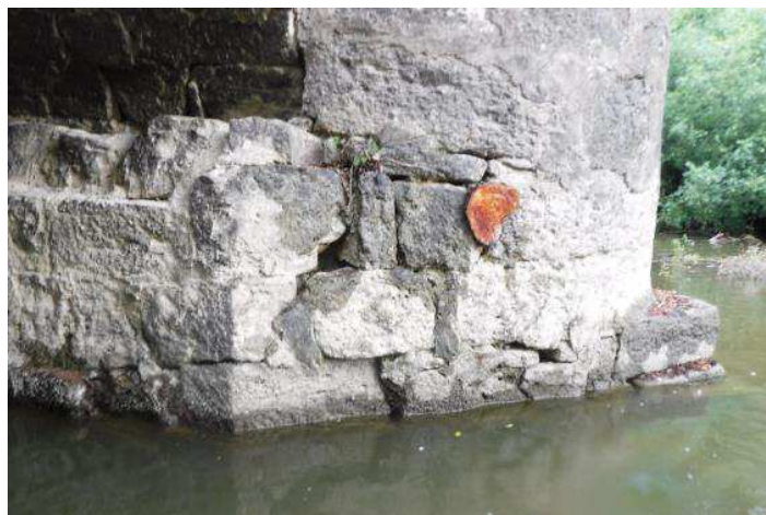
Imagen 9. Aspecto de la base de la pila y arranque de la bóveda 1.
