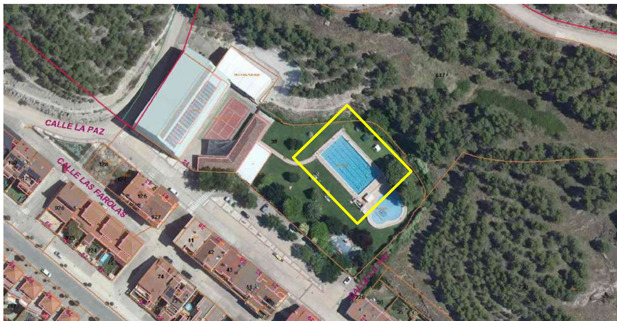
Ilustración 2: Situación de la zona de estudio y zona donde se concentran las patologías principales. ( https://catastro.navarra.es )
