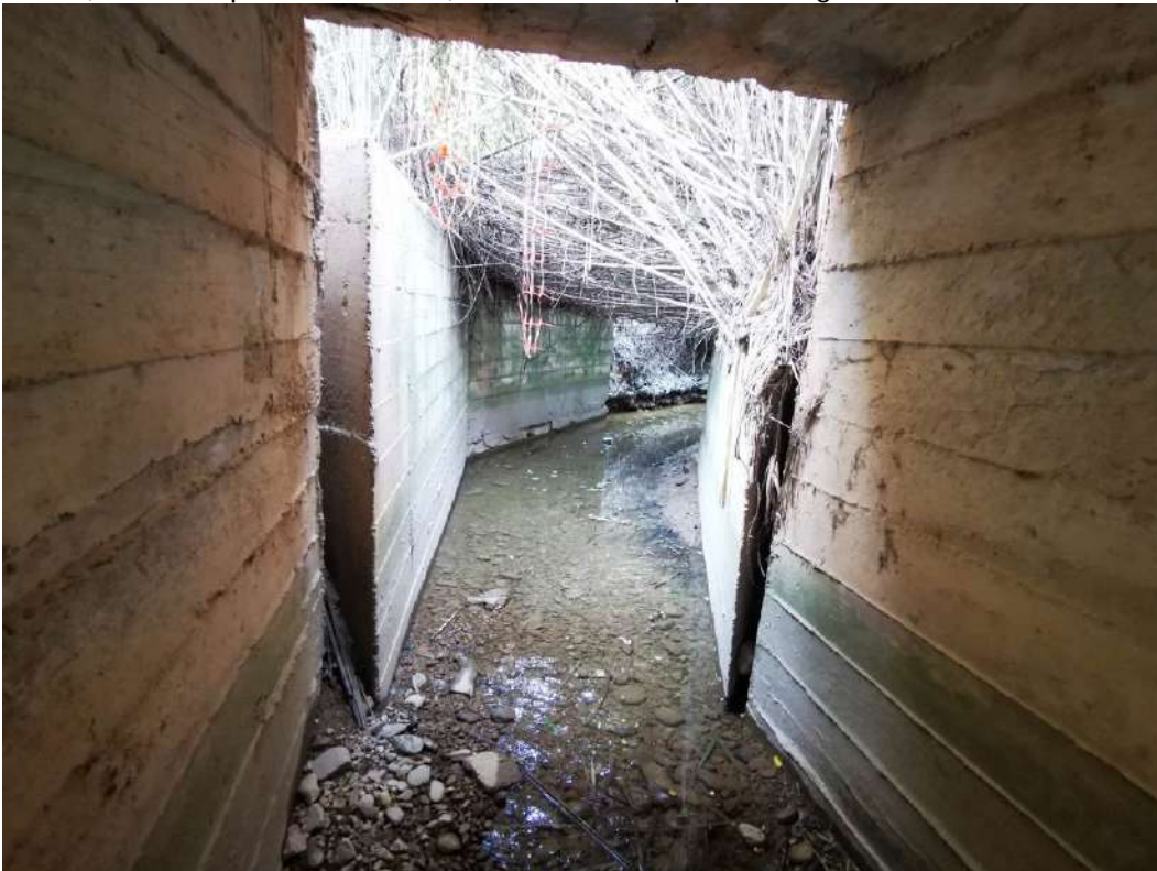
Tramo de acequia hormigonada en la zona de obra de fábrica. Las impostas y muros de acequia son independientes.
