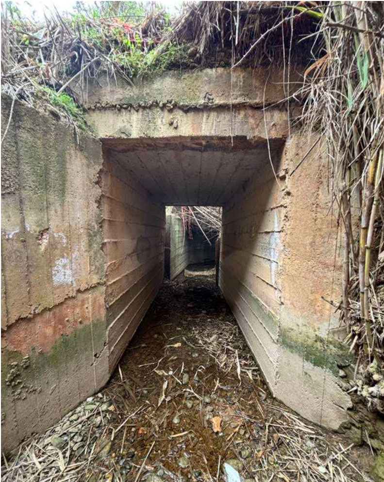
En la imagen anterior, vista desde aguas abajo hacia la obra de fábrica, se aprecian las aletas, muros, losa e imposta. Al fondo, tramo de acequia hormigonada en la zona de entrada.
