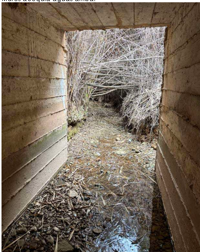
Vista desde el interior de la obra de fábrica en sentido aguas abajo. Acequia en tierras. (Zona prevista para ampliación)
