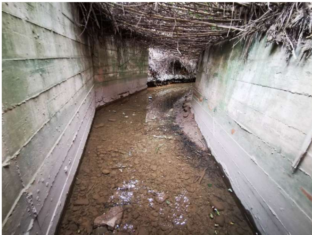
Muros acequia aguas arriba.
