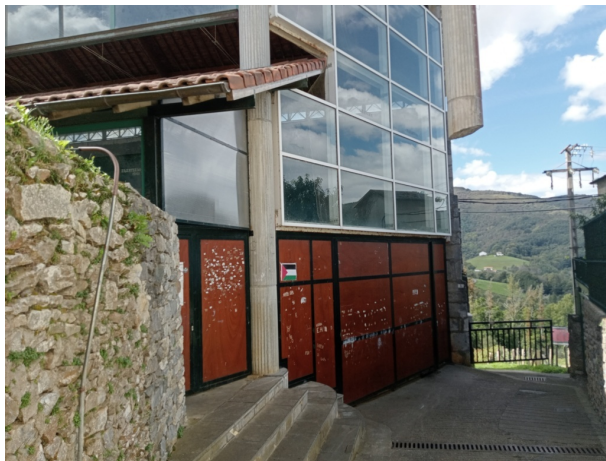
Vista exterior del frontón.
