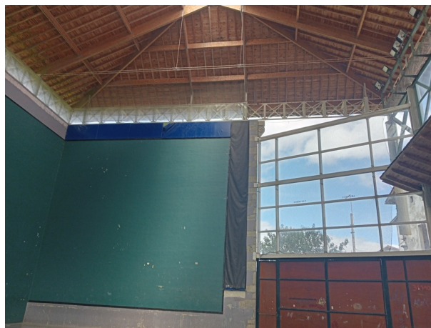
Vista interior del frontón. Frontis.
