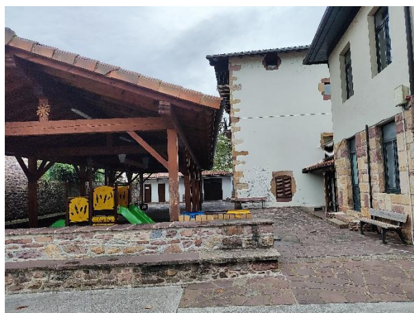
Fig. 2.3 Fachadas este y porche posterior
