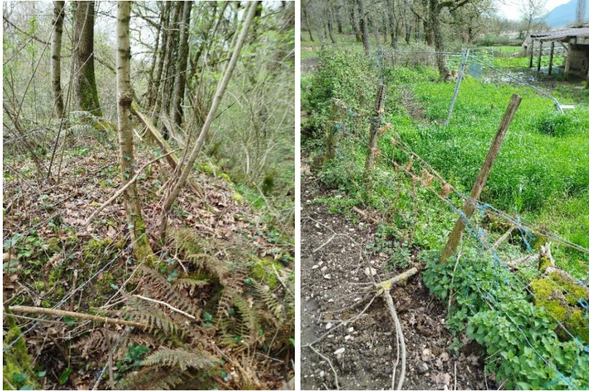
ILUSTRACIÓN 1. ESTADO ACTUAL DEL CIERRE DE BEHEKO BASOA QUE HAY QUE RETIRAR E INSTALAR UNO NUEVO.
