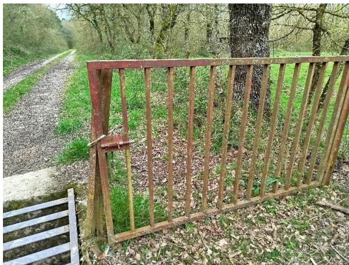
ILUSTRACIÓN 4. ESTADO ACTUAL DE LA PUERTA METÁLICA QUE SE TIENE QUE CAMBIAR.
