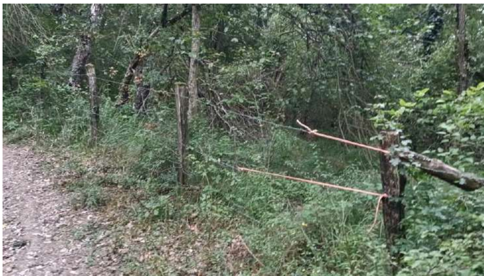
Foto 3: Cierre de Aristregui con numerosas reparaciones con cuerda hechas por el ganaderos y Ayto.
