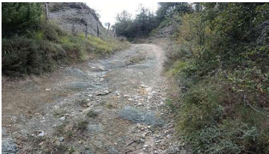
Foto 5: Camino Marcalain-Larrayoz, tramo donde se ha previsto actuación
