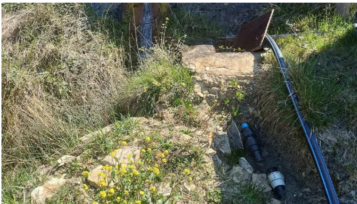
Foto 1: Zona para realizar la toma desde el depósito viejo en Usi
