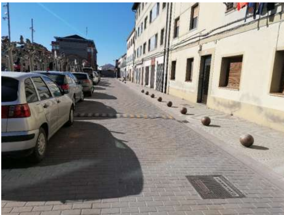
IMPLANTACIÓN DE RED DE PLUVIALES EN EXTREMO NORTE DE LA PLAZA ESPAÑA
