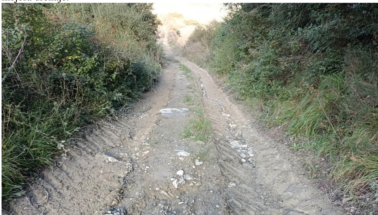
Foto 4: Camino de Larrayoz-Osinaga a mejorar el firme
