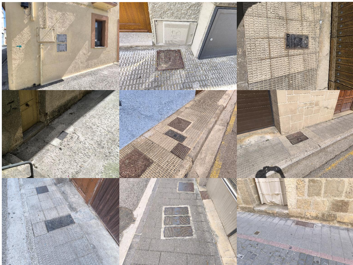
Ilustración 2. Contadores ubicados en arqueta metálica en el municipio
