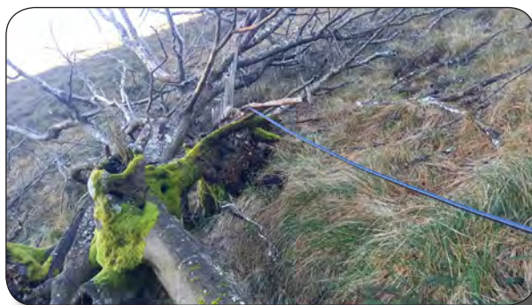
Derribo fortuito de haya y alteración de la tubería
