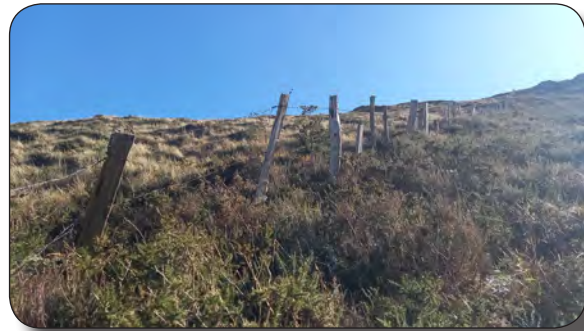
Piquetes podridos y alambres desclavados, especialmente el inferior
