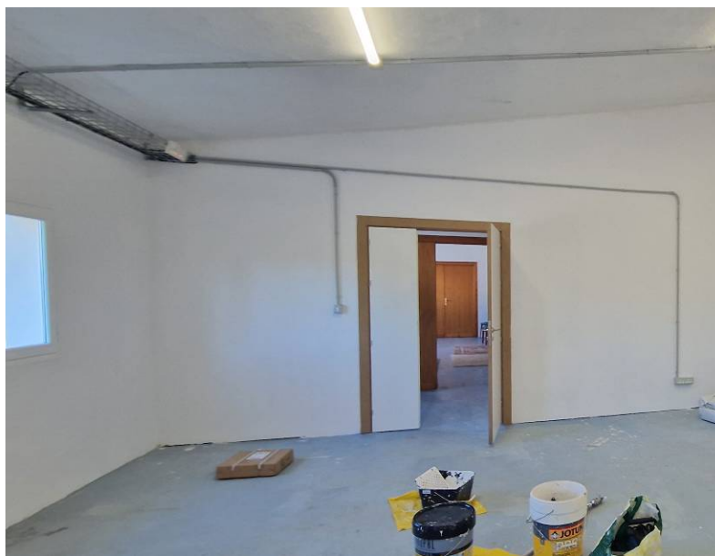
Puerta de acceso a Local 10
