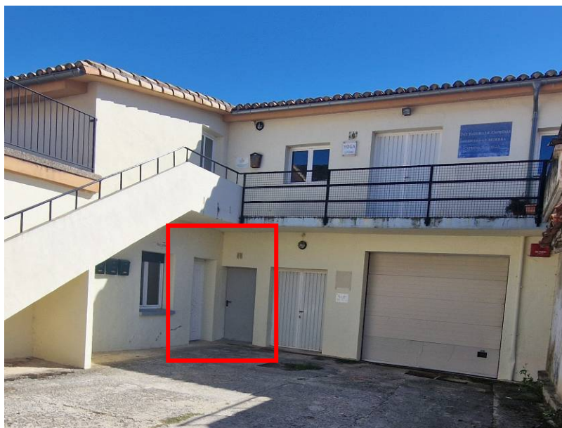
Puertas de acceso a Vestuarios y Local 3 a 90°
