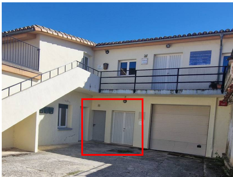
Puertas de acceso a Local 3 y Vestíbulo PB a 180°
