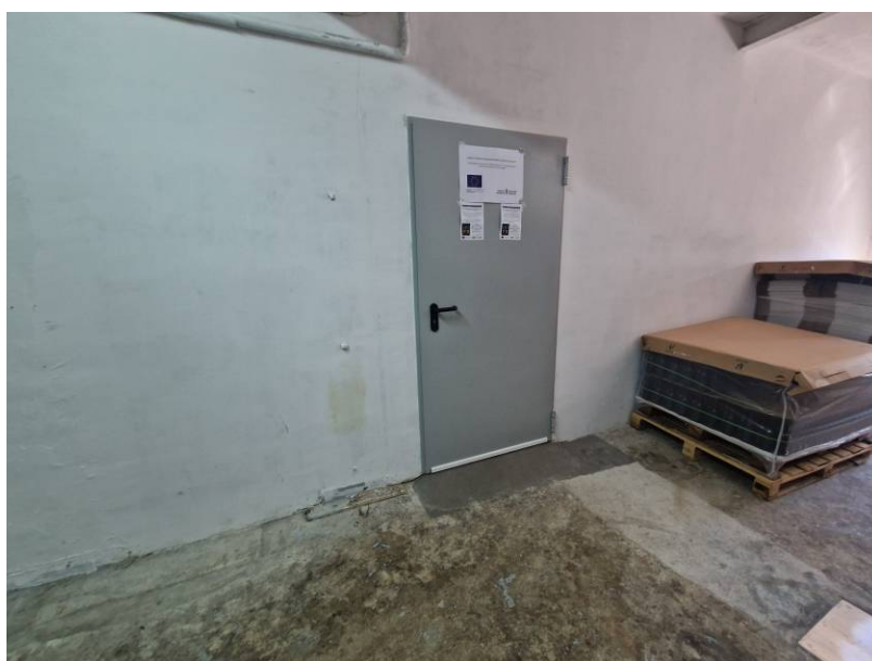
Puerta de acceso a Local 4
