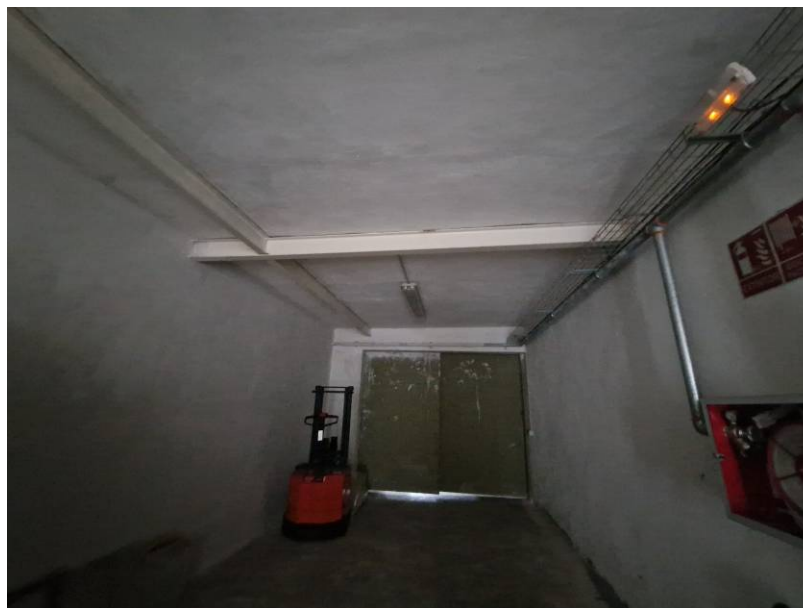
Refuerzo de forjado
