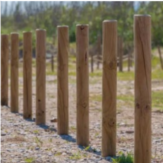
Imagen de postes de cierre de tráfico
