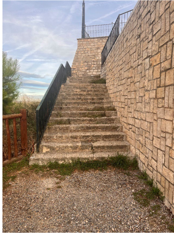
Escaleras de acceso a la ZI 1 desde la ZI2
