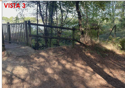
IMAGEN DEL ESTADO ACTUAL (VALLADO)
