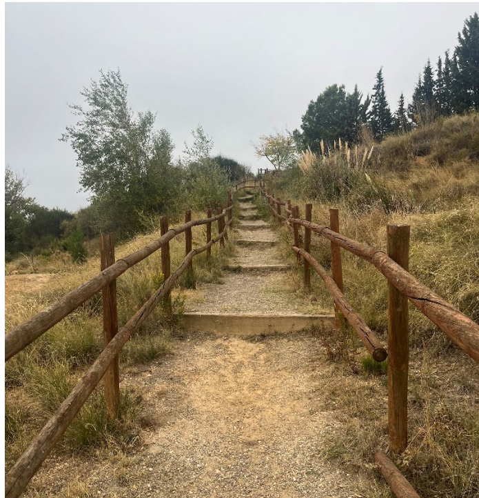
Erosión de terreno en peldaños
