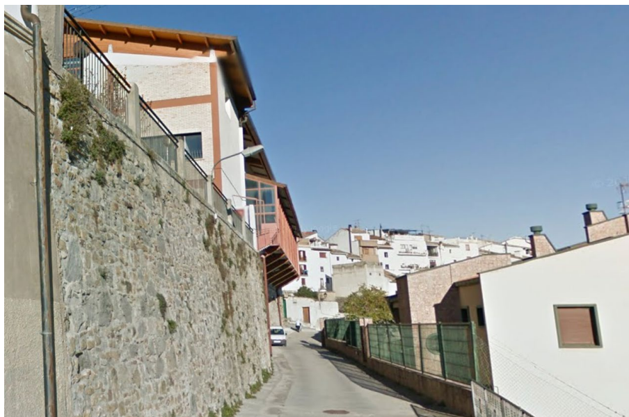
30 Muro de contención de la Plaza del Abrigo desde la Calle Cruces
