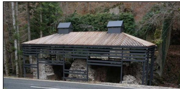
Cubierta protectora del edificio de hornos consolidado: 2021.
