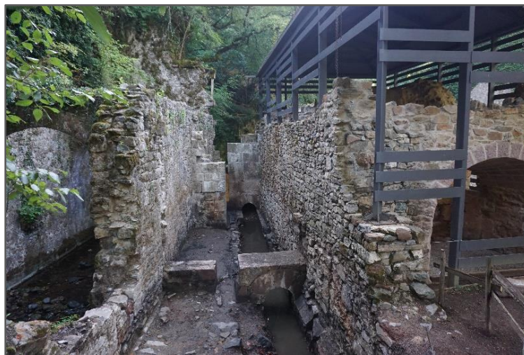
2023.- Registro del espacio del canal de hornos -Zona J- de O-E.
