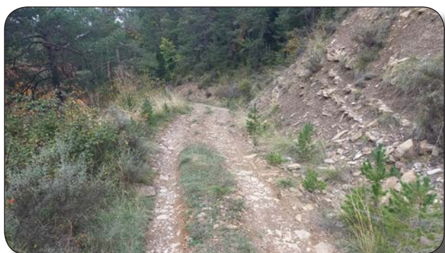
TRAMOS 14 (95 ml) - 15 (80 ml) - 16 (290 ml) Los tramos 14 y 16 tienen la cuneta colmatada y la plataforma irregular mientras que en el 15 carece de cuneta
