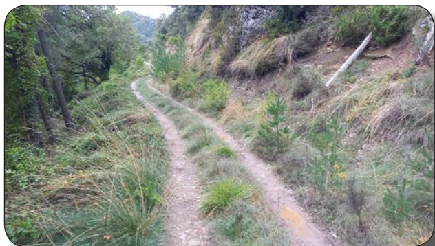
TRAMO 19 (340 ml) Tramo angosto a lo largo de lecho calizo y sin cuneta
