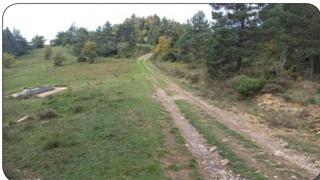
TRAMO 8 (30 ml) En la depresión existe un blandón por la concurrencia de escurrimientos de ambos sentidos
