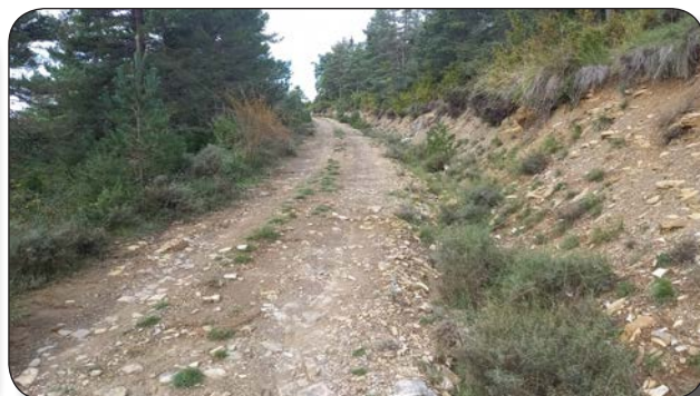
TRAMO 7(940 ml) Aunque de escasa pendiente presenta un estado irregular con zonas aceptables, otras algo sobresaturadas de humedad y otras con afloramientos de áridos gruesos. La cuneta presenta acumulaciones puntuales
