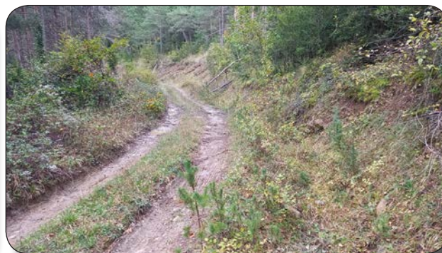
TRAMO 20 (105 ml) Plataforma algo más ancha con cuneta que presenta aterramientos puntuales
