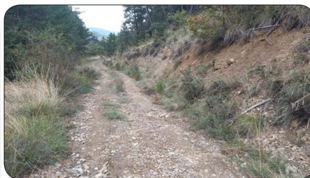
TRAMOS 14 (95 ml) - 15 (80 ml) - 16 (290 ml) Los tramos 14 y 16 tienen la cuneta colmatada y la plataforma irregular mientras que en el 15 carece de cuneta
