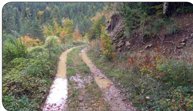
TRAMO 13 (35 ml) Rodadas marcadas con acumulaciones de agua. Plataforma muy estrecha
