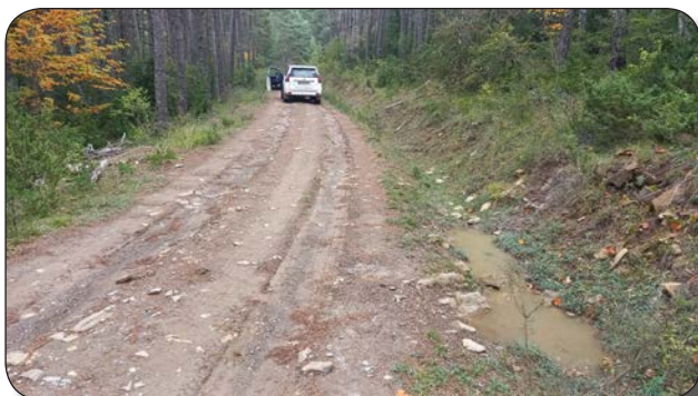
TRAMO 7(940 ml) Aunque de escasa pendiente presenta un estado irregular con zonas aceptables, otras algo sobresaturadas de humedad y otras con afloramientos de áridos gruesos. La cuneta presenta acumulaciones puntuales
