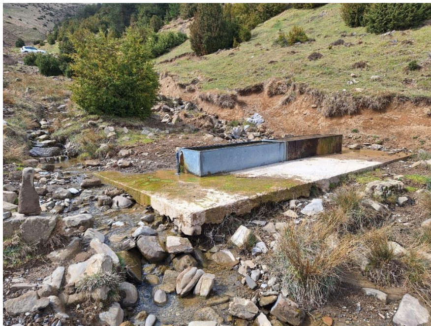
Imagen 2: Barranco de la Muidera de Froilan. Abrevadero existente. Se observan los laterales de la placa que es preciso reforzar.-
