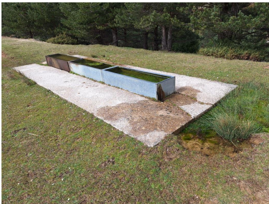
Imagen 4: Orabale. Abrevadero existente. El nuevo se instalará adosado en cabecera.-
