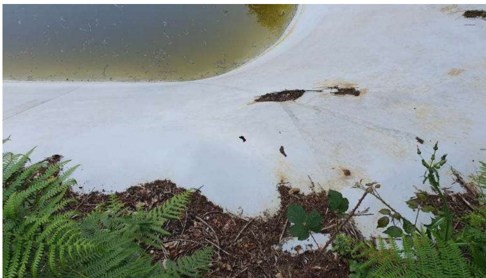
Fotografía del estado actual de la balsa de Larramingo.
