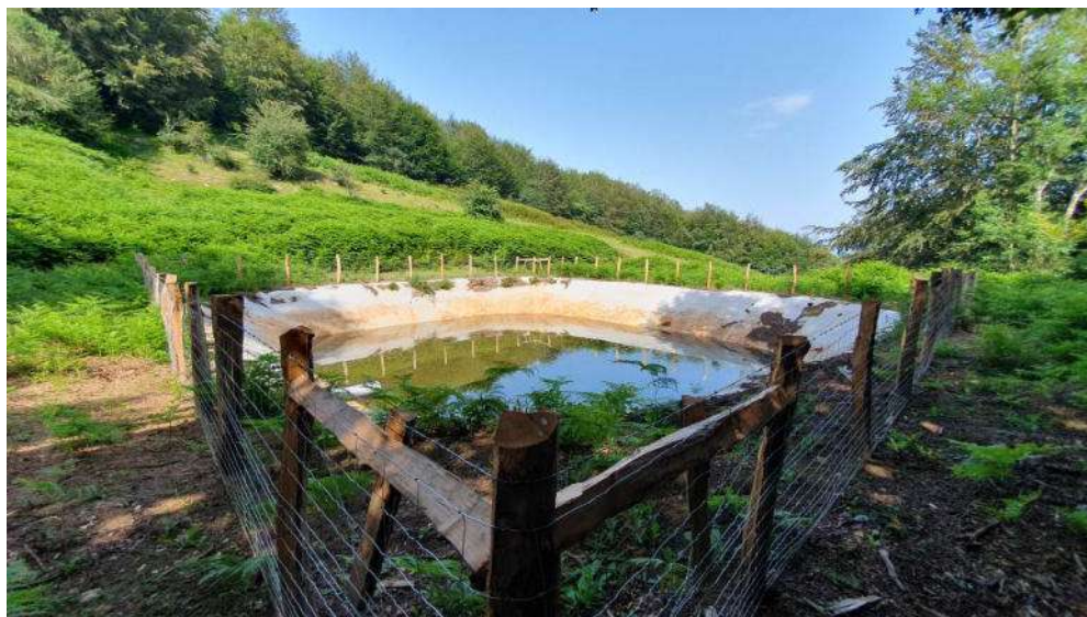
Fotografía del estado actual de la balsa de Soroaundi.
