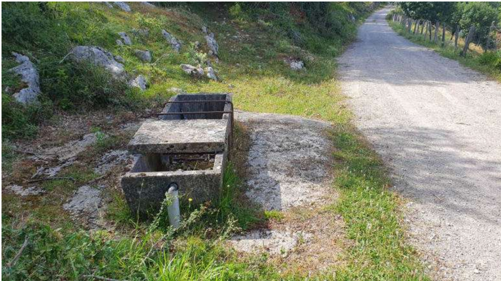
Fotografía del estado actual del abrevadero de Soroaundi.
