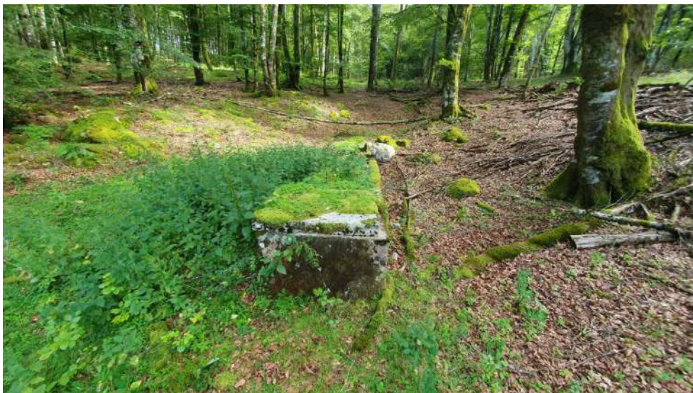
Fotografía del estado actual de la captación de Larramingo.
