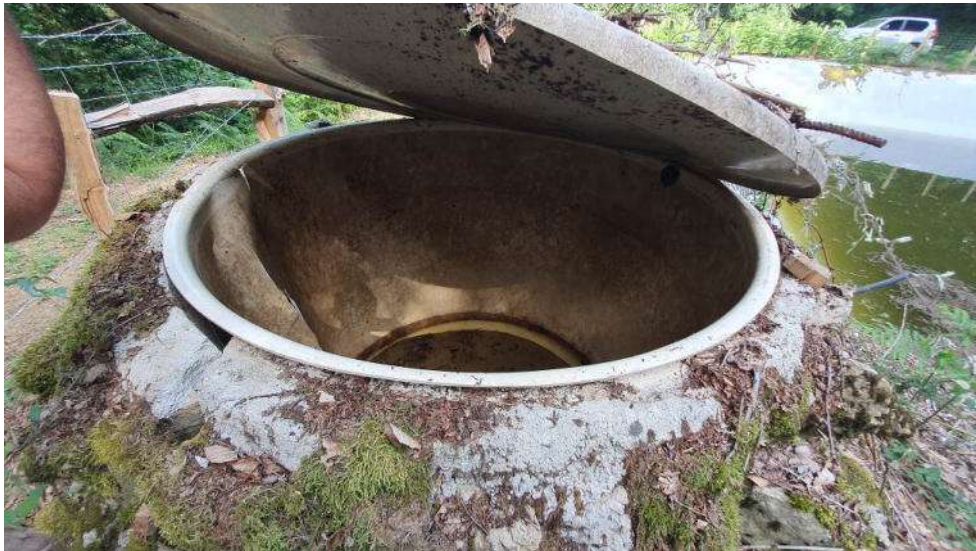
Fotografía del estado actual del depósito de Larramingo.
