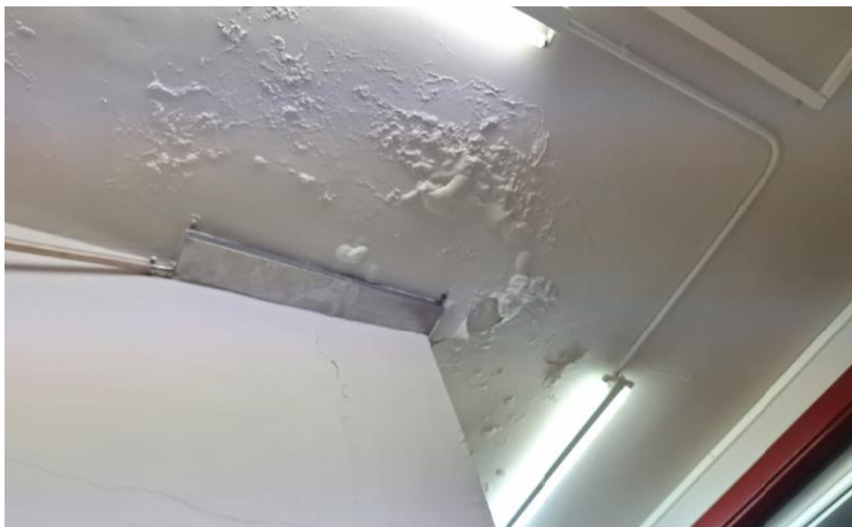
Canaleta interior de recogida de aguas de filtración.
