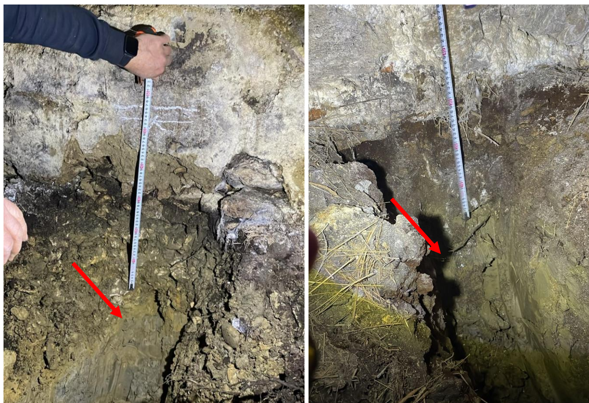
Ilustración 2: Calicata 1 y calicata 2 indicando el nivel de apoyo del muro
