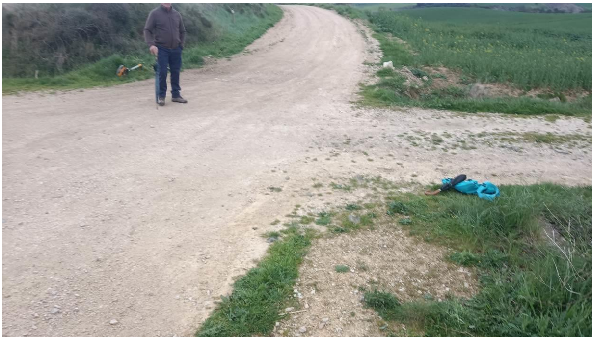
Foto 2. Cruce fincas y caminos con paso de tubos para drenaje
