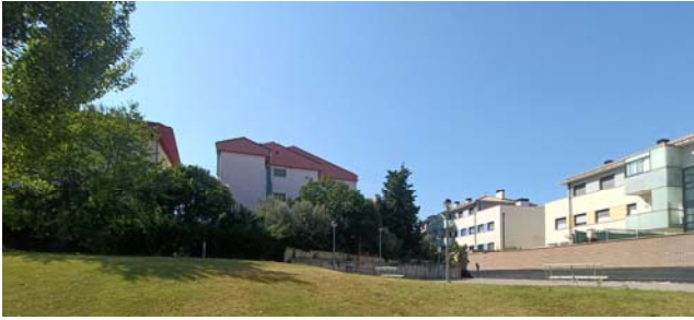
VISTA DESDE LA URBANIZACIÓN INTERIOR. FACHADA ESTE
