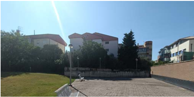
VISTA DESDE LA URBANIZACIÓN INTERIOR. FACHADA ESTE
