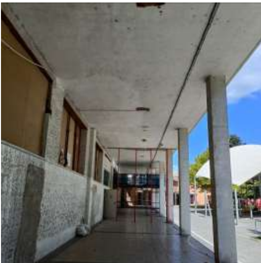
Fachada sur. Local existente. Vista hacia el este
