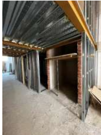
Interior del local. Entreplanta existente chapa colaborante
