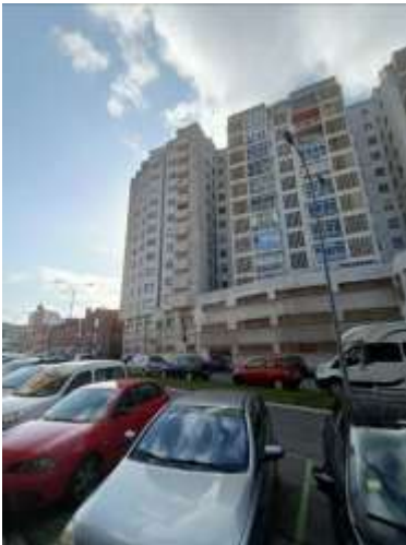
Bloque viv. Fachada norte
