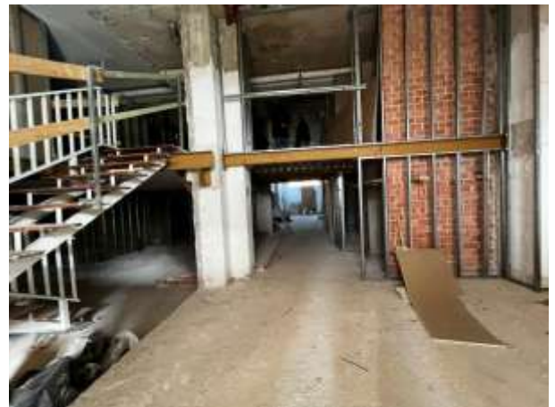
Interior del local. Salto junta de dilatación. Entreplanta existente
