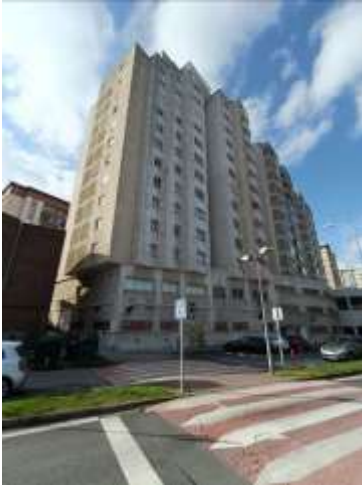
Bloque viv. Fachada norte y este
