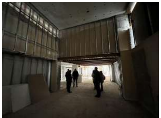
Interior del local. Zona sur. Entreplanta existente. Vista hacia el este
