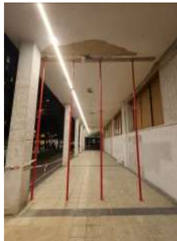
Porche. Fachada sur local centro de día
