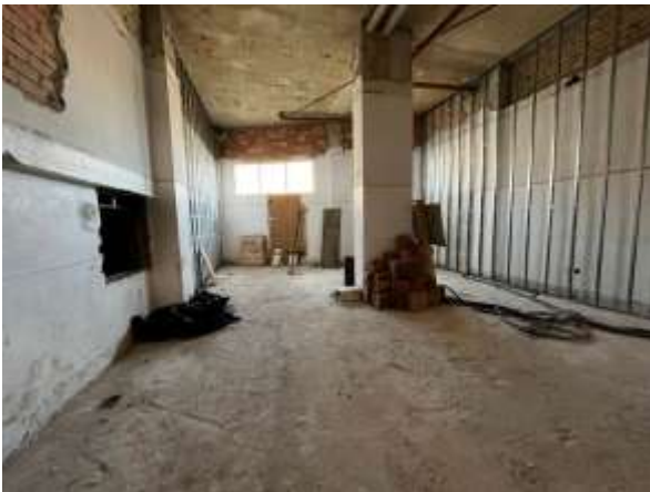
Interior del local. Fachada norte
