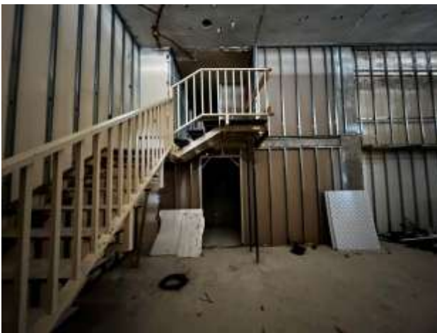
Interior del local. Zona este. Escalera entreplanta
