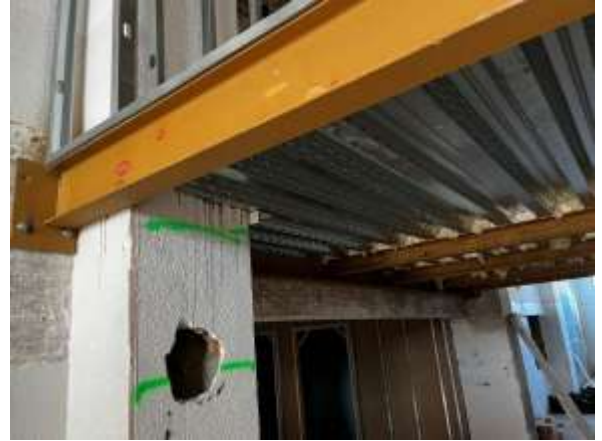
Interior del local. Zona central. Entreplanta
