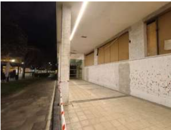
Porche. Fachada sur local centro de día
