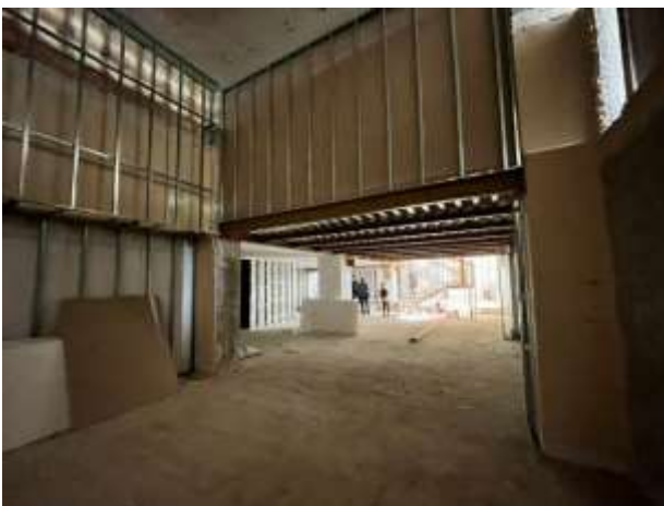
Interior del local. Zona sur. Entreplanta existente. Vista hacia el este
