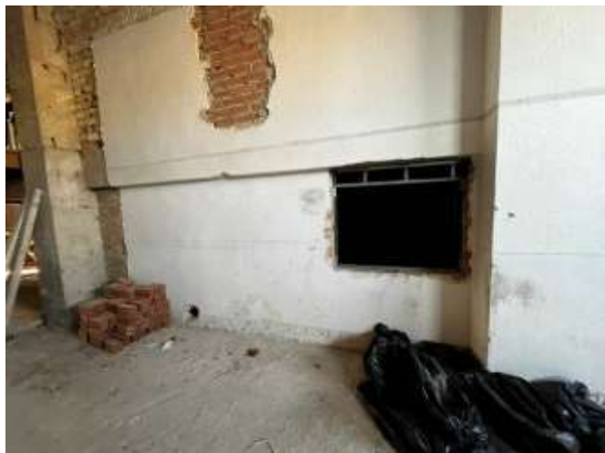
Interior del local. Zona central. Entreplanta
