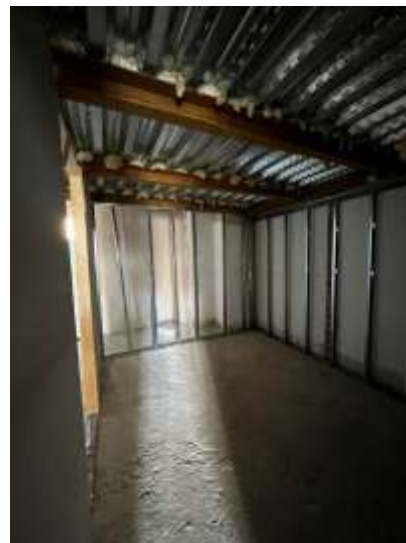
Interior del local. Zona central. Entreplanta
