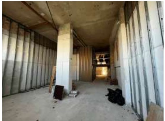
Interior del local. Vista hacia el sur, desde zona norte
