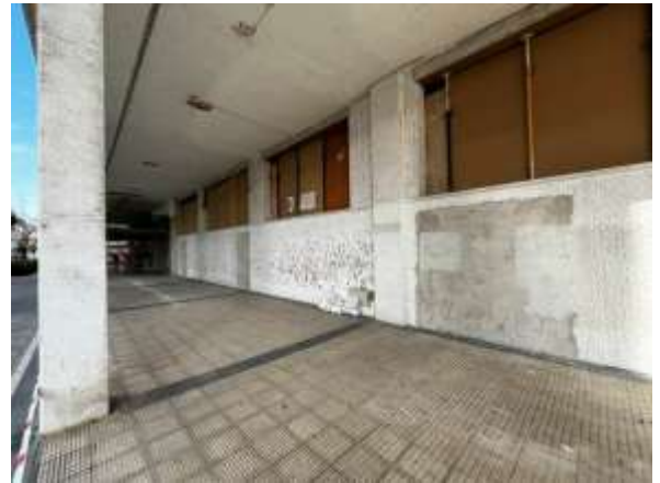
Fachada sur. Local existente
