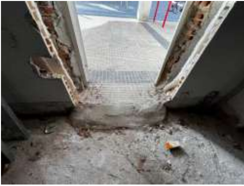
Interior del local. Puerta existente porche sur
