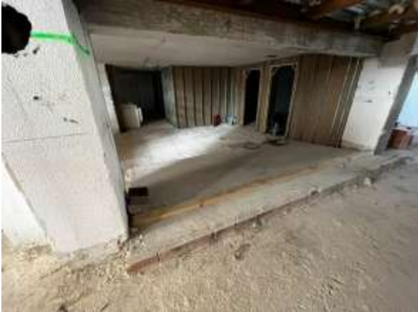
Interior del local. Zona central. Entreplanta existente de estr. Horm/vigueta y bov.
