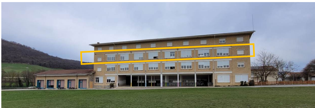
Fotografía 01. Vista general del edificio. Planta segunda.
