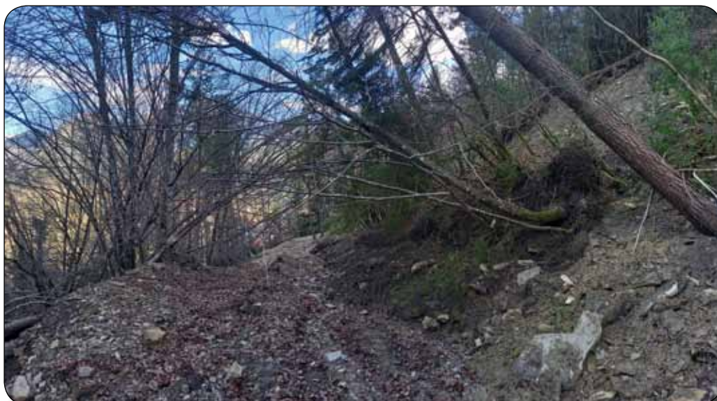
Tramo 3. Tras la curva anterior nuevo deslizamiento de ladera
