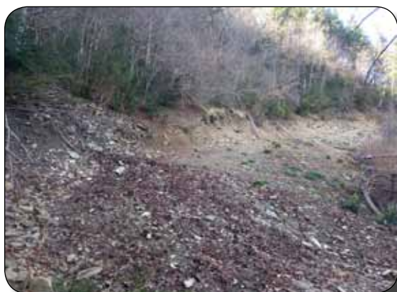
Tramo 3. Despredimiento de rocas del talud de desmonte y alteración ligera del perfil de la calzada
