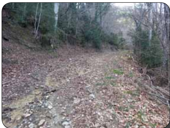
Tramo 2. Drenajes superficiales mermados
