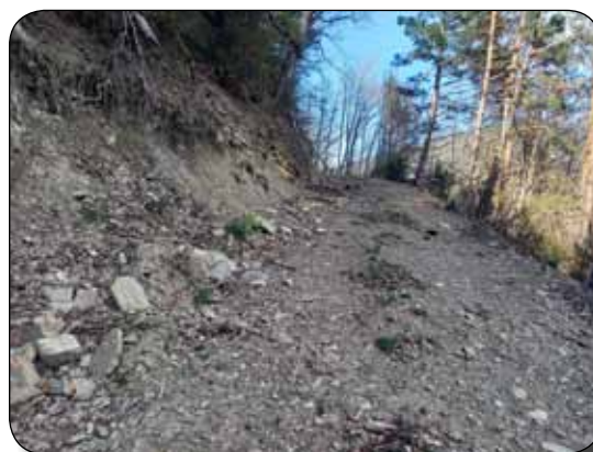
Tramo 3. Despredimiento de rocas del talud de desmonte y alteración ligera del perfil de la calzada
