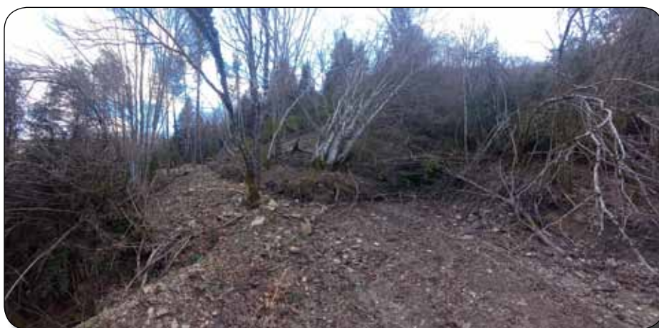
Tramo 3. Deslizamiento de tierra y arbolado sobre la calzada
