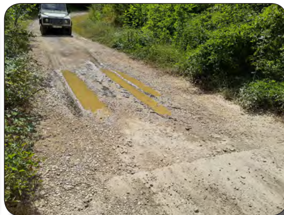
Bache tras puente de hormigón
