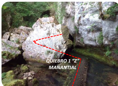
F12. Dado tuberías conforman azud superior
