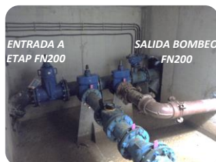
F7 registro del sondeo Iribas P3 (bomba de 95Kw) y registro adyacente paso a ETAP y antigua conexión a depósito previo a la ETAP.
