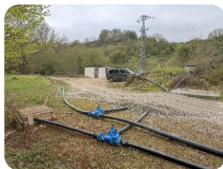
F8 Final aéreo PEØ110mm caseta Iribas a ETAP. Bypass PEØ90mm bombeo canal + PEØ110mm a dep. tratada y modificación entrada x pared
