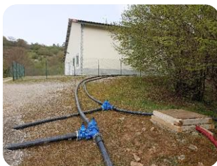
F8 Final aéreo PEØ110mm caseta Iribas a ETAP. Bypass PEØ90mm bombeo canal + PEØ110mm a dep. tratada y modificación entrada x pared
