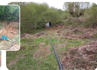
F9 200ml aéreo PEØ110mm entre caseta Iribas a ETAP. Tramo por campo y conex. camino en ODT
