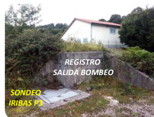
F7 registro del sondeo Iribas P3 (bomba de 95Kw) y registro adyacente paso a ETAP y antigua conexión a depósito previo a la ETAP.
