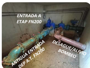
F7 registro del sondeo Iribas P3 (bomba de 95Kw) y registro adyacente paso a ETAP y antigua conexión a depósito previo a la ETAP.
