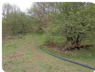
F9 200ml aéreo PEØ110mm entre caseta Iribas a ETAP. Tramo por campo y conex. camino en ODT
