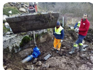
F5 Reparación 2019 PVC200 barranco Iribas
