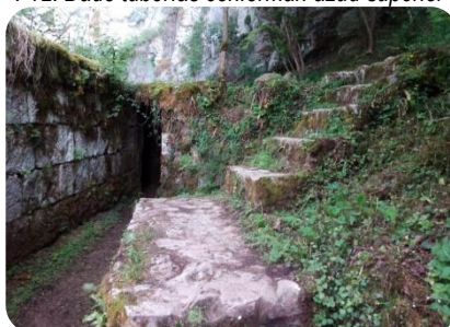
F15. Salida tuberías al otro lado del muro.
