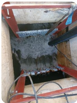
F1 Montaje provisional jaula en registro 70x70cm en canal para bombeo por aéreo a cámara de mezcla
