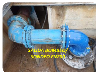
F7 registro del sondeo Iribas P3 (bomba de 95Kw) y registro adyacente paso a ETAP y antigua conexión a depósito previo a la ETAP.
