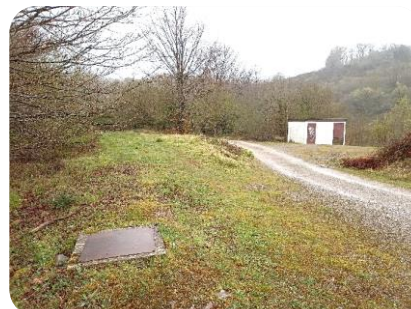
F4 Reg. canal a camino y CT
