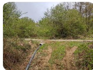
F9 200ml aéreo PEØ110mm entre caseta Iribas a ETAP. Tramo por campo y conex. camino en ODT
