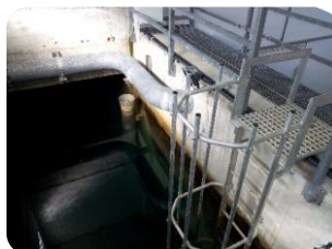
F7 Vista pasarela superior vasos y acceso. Llenado por sonda nivel depósito.
