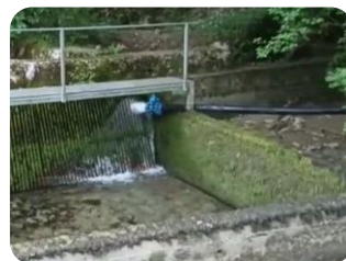
F10 Montaje compuerta provisional manantial (madera + sacos arena) y derivación aérea PEØ90mm 75ml por cauce hasta entrada azud canal.
