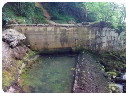
F13. Dado tuberías conforman azud superior
