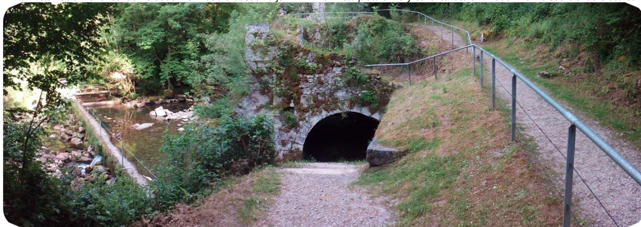
F20. Vista desde final pista rodada del azud central hidroeléctrica (MI), acceso antiguo molino (centro) y pista hacia manantial (drcha.). Por esta pista peatonal (podría permitir el paso maquinaria pequeña al mirador) es por donde bajan las tres conducciones, a priori, ya renovadas.
