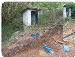
F9 200ml aéreo PEØ110mm entre caseta Iribas a ETAP. Tramo por campo y conex. camino en ODT
