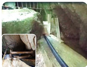
F10 Montaje compuerta provisional manantial (madera + sacos arena) y derivación aérea PEØ90mm 75ml por cauce hasta entrada azud canal.
