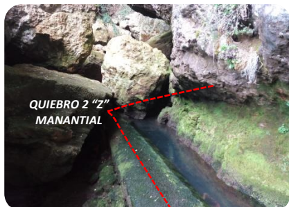
F11. Salida dado protección tuberías.
