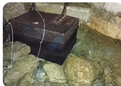
F8. Vista detalle rejilla y conducciones toma en época de estío.
