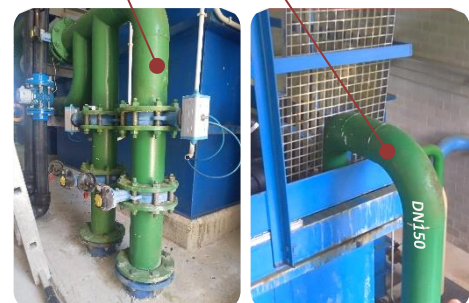
F12. Entrada manantial y sondeo + unificación.
