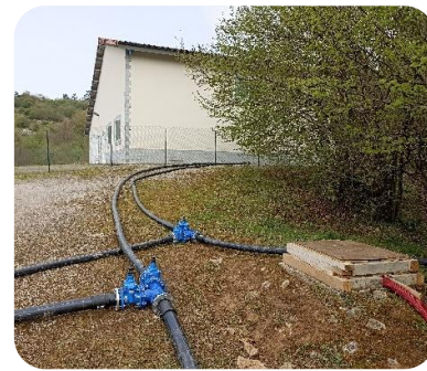
F1 Montaje provisional jaula en registro 70x70cm en canal para bombeo por aéreo a cámara de mezcla
