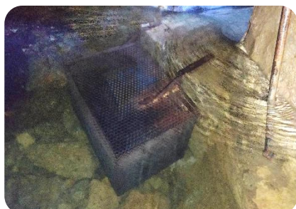
F7. Vista general rejilla metálica captación
