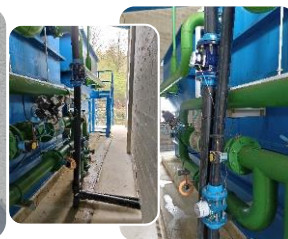
F8 Final aéreo PEØ110mm caseta Iribas a ETAP. Bypass PEØ90mm bombeo canal + PEØ110mm a dep. tratada y modificación entrada x pared
