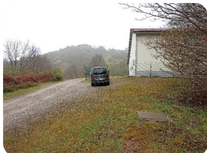
F2 Vista espacio registro canal a ETAP
