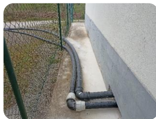
F8 Final aéreo PEØ110mm caseta Iribas a ETAP. Bypass PEØ90mm bombeo canal + PEØ110mm a dep. tratada y modificación entrada x pared
