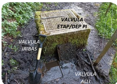
F16. Registros de las tres tuberías salida dado hor. en verja mirador molino
