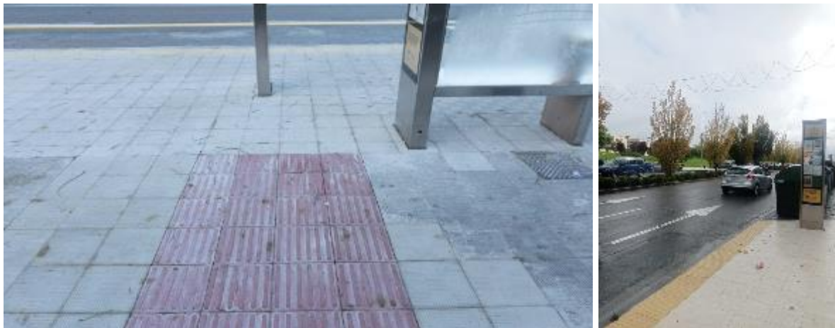
Banda de acanaladura para detección de la parada de autobús y señalización de bordillo.
