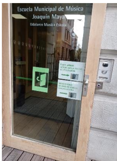
Puerta automática con pulsador en la Escuela Municipal de Música Joaquín Maya. Fuente: propia
