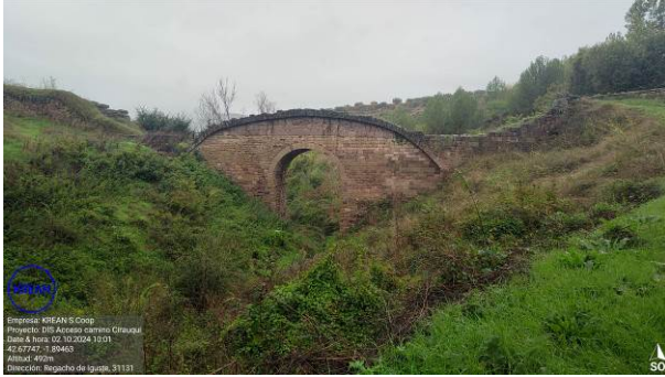
Figura 1: Puente de Piedra
