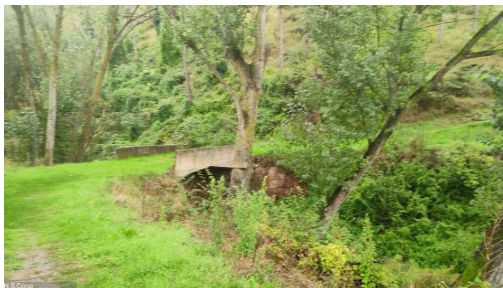
Figura 5: Paso sobre regata
