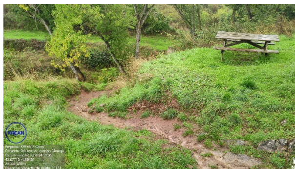
Figura 9: Bajada actual a paso sobre regata
