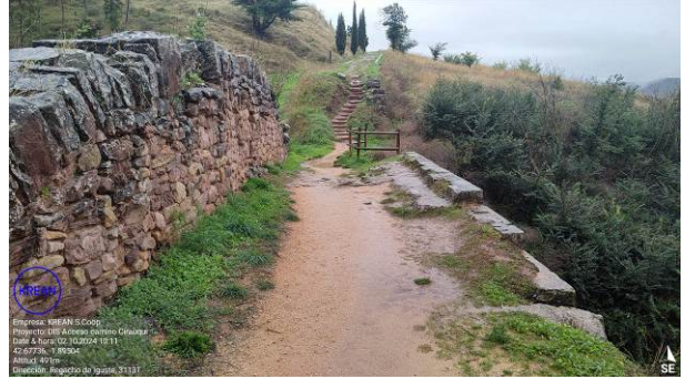
Figura 2: muro lateral puente
