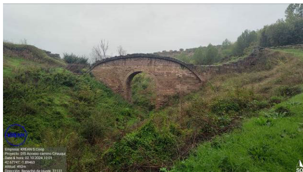
Figura 2: Puente de Piedra
