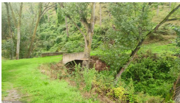
Figura 6: Paso sobre regata
