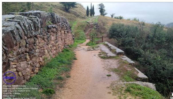
Figura 3: muro lateral puente
