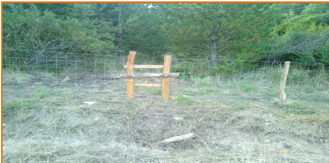
Imagen 1: Detalle de paso para personas tipo "escalera"
