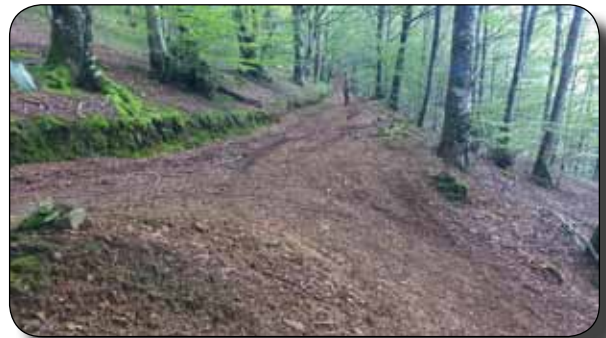
Entronque con vía de saca que discurre a media ladera
