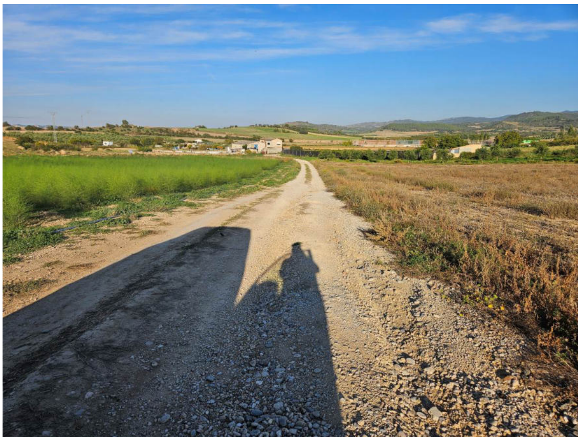
Camino donde la riada ha erosionado la capa de rodadura
