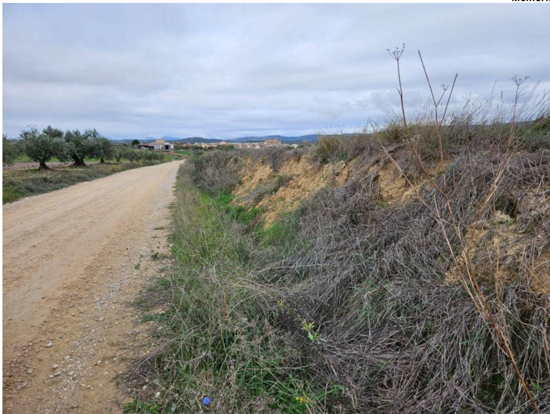
Camino donde la riada ha erosionado la capa de rodadura y las cunetas están con tierras. No va a ser necesario aporte de áridos
