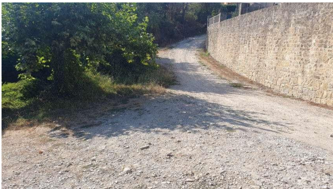
Imagen de Galdairu 2 a pavimentar
