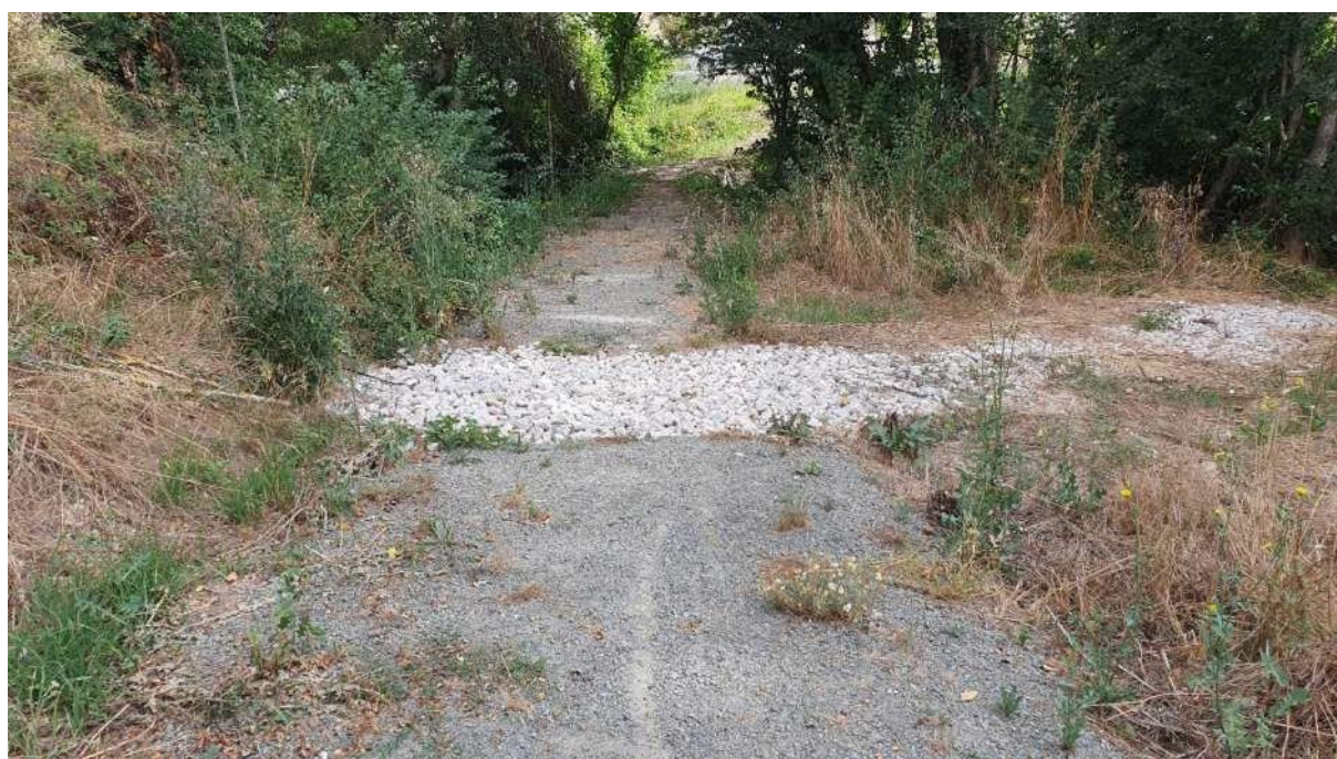
Imagen donde se aprecia la necesidad de perfilado
