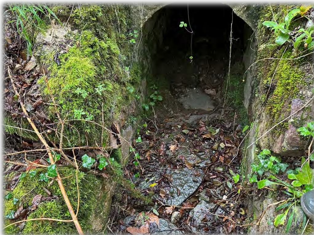
Fotografía 10: Vista de la obra de fábrica.
