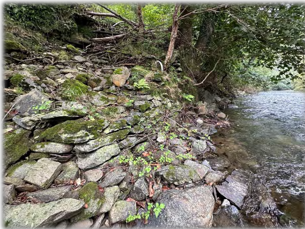
Fotografía 6: Vista de lo que queda de muro de mampostería, mirando aguas abajo.
