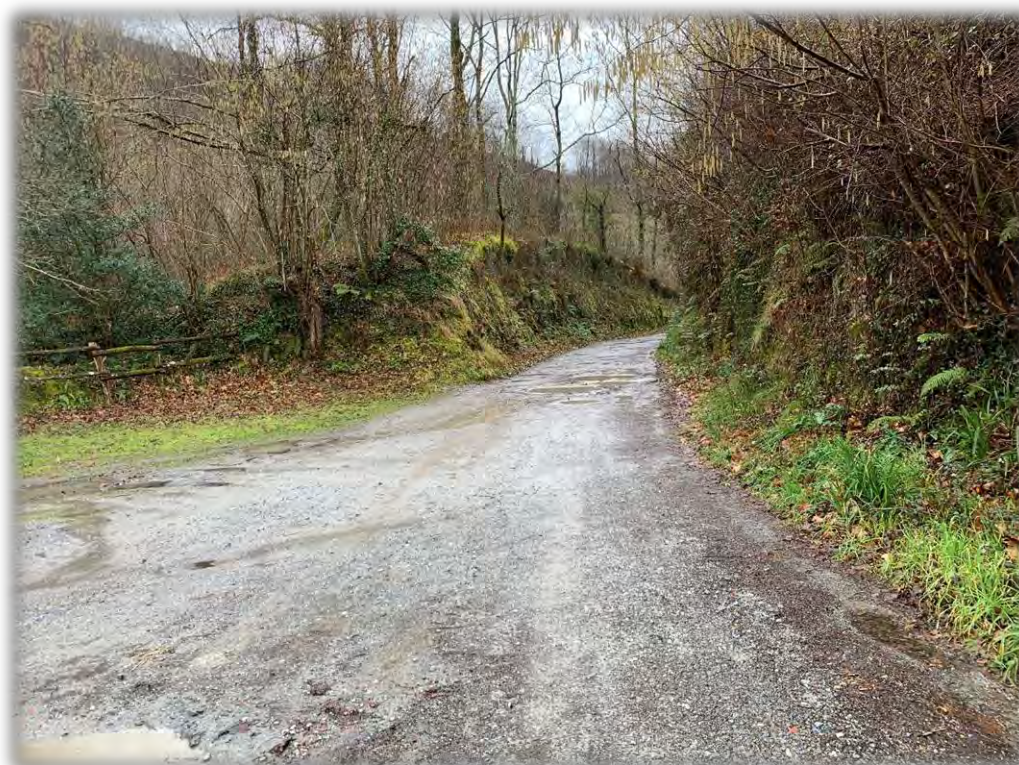
Fotografía 3: Trinchera en la que modificar la pendiente longitudinal de la Vía Verde.
