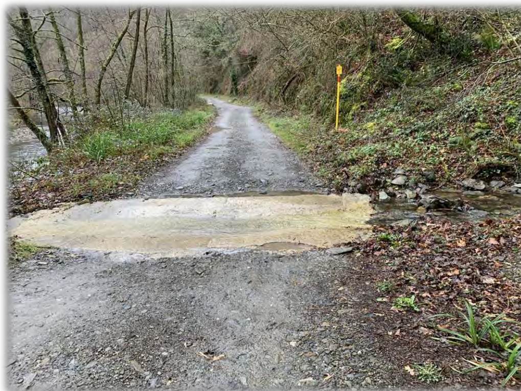
Fotografía 4: Vado a reconstruir en el PK 9+270.
