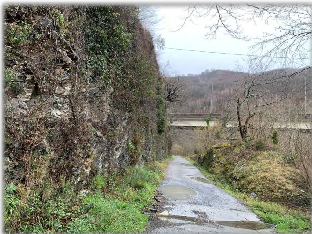
Fotografía 1: Trinchera en la que modificar la pendiente longitudinal de la Vía Verde.
