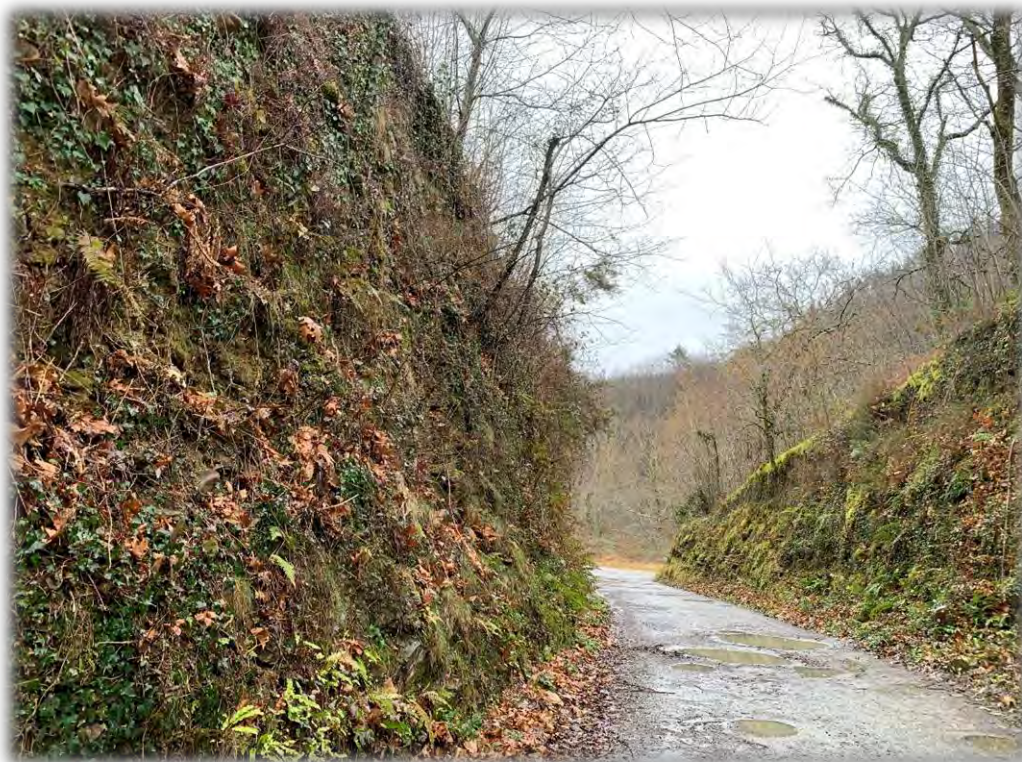
Fotografía 2: Trinchera en la que modificar la pendiente longitudinal de la Vía Verde.
