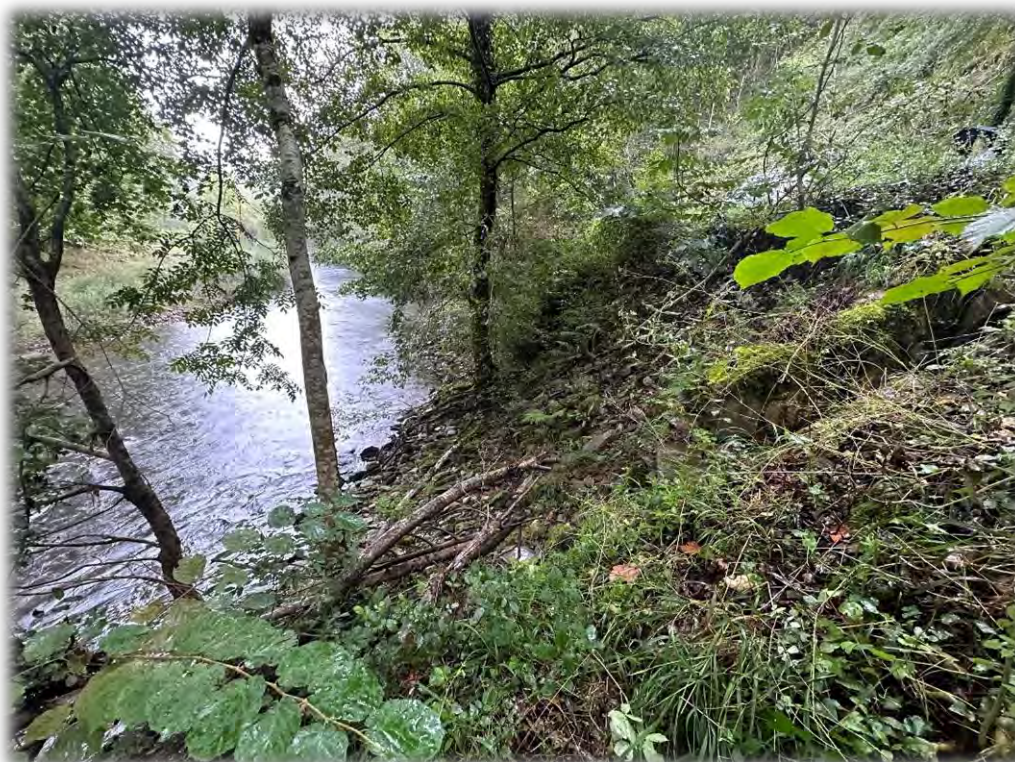
Fotografía 8: Talud visto desde las aletas del drenaje que recoge a Burdinzelaietako Erreka.
