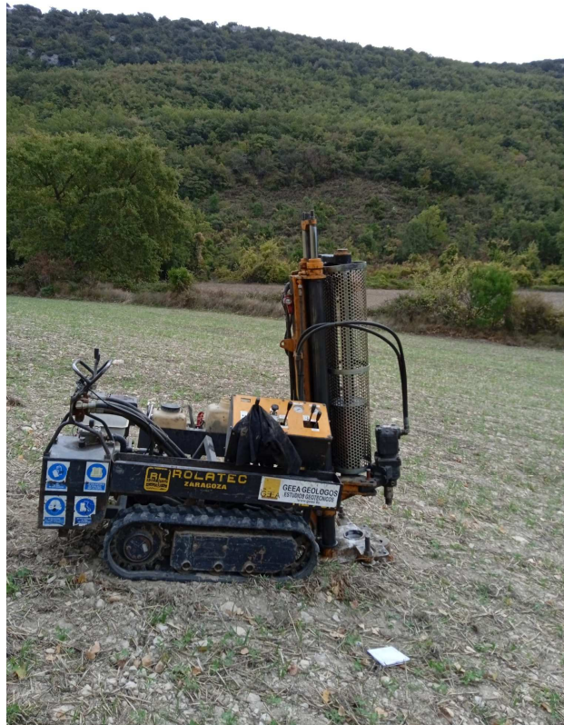
Ensayo de penetración DPSH P1
