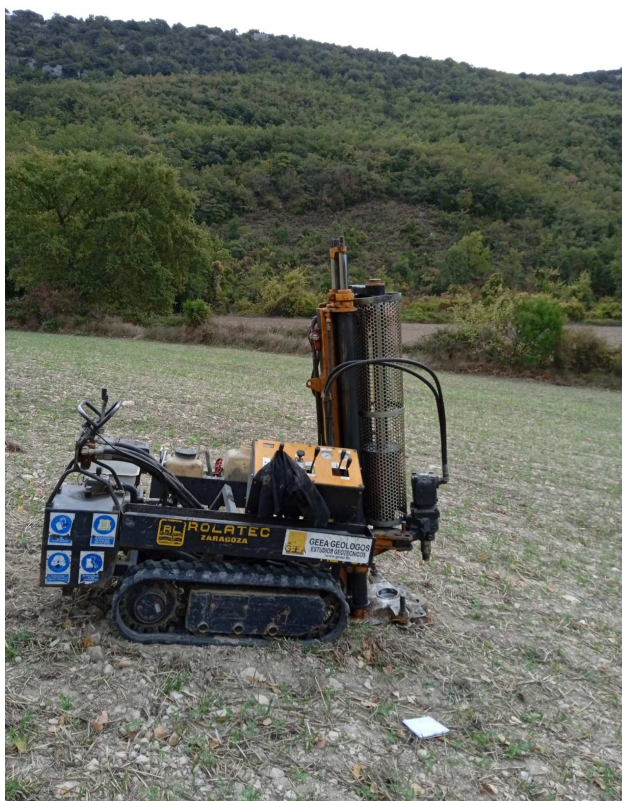
Ensayo de penetración DPSH P1
