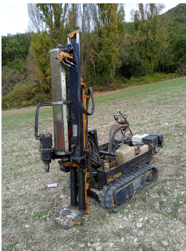
Ensayo de penetración DPSH P2
