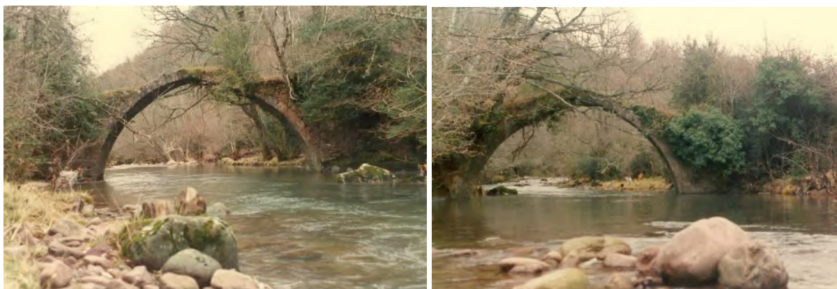
Imágenes de los alzados del puente del año 1993, antes del colapso, en el que se aprecia la cantidad de vegetación que ha crecido en la propia construcción. Izquierda: aguas arriba. Derecha: aguas abajo. Fotografías de Juan Martínez Txoperena.
