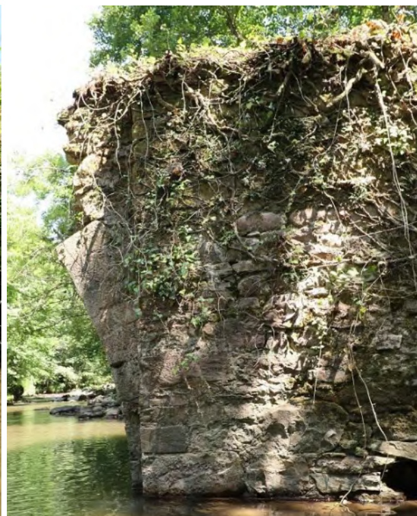
Fábrica de los tímpanos y estribos. Izquierda: margen derecha. Derecha: margen izquierda.
