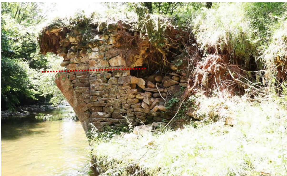
Imagen en la que se ve el cambio del tipo de fábrica del muro de la aleta y del tímpano de la margen derecha aguas arriba.
