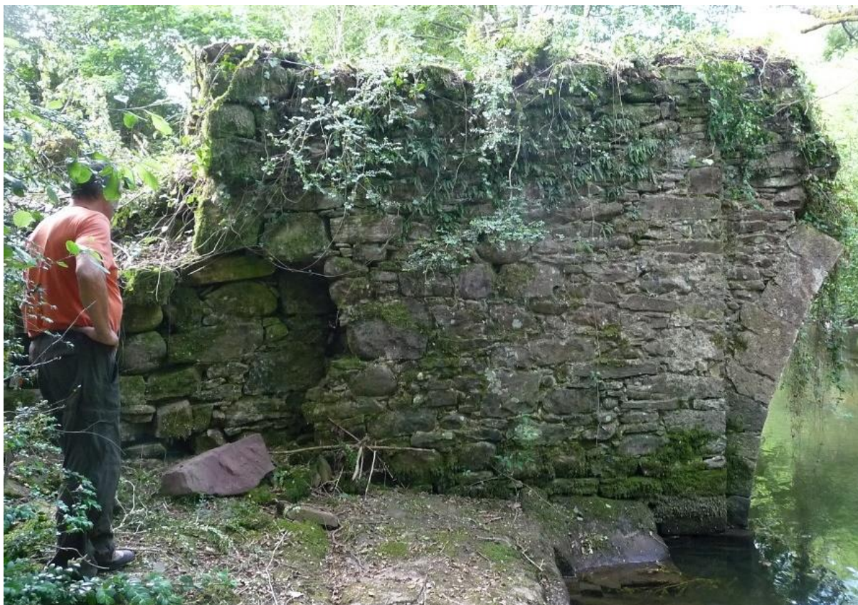
Imagen en la que se aprecia el cambio de plano y de tipo de fábrica del muro de la aleta de la margen izquierda aguas arriba.
