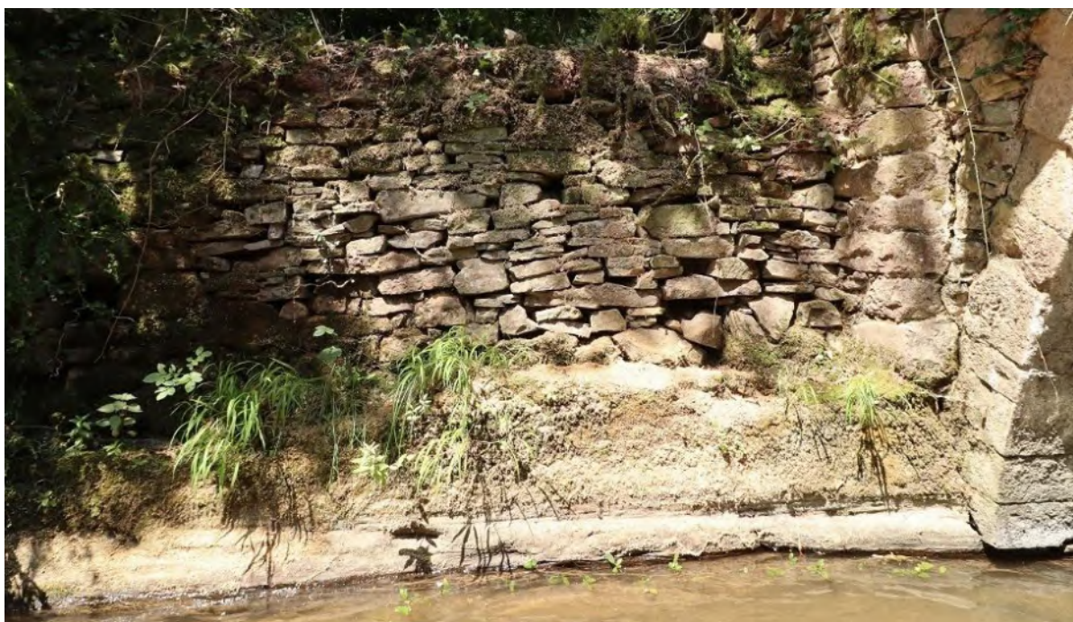
Fotografía de la parte del muro de contención adosada al puente.
