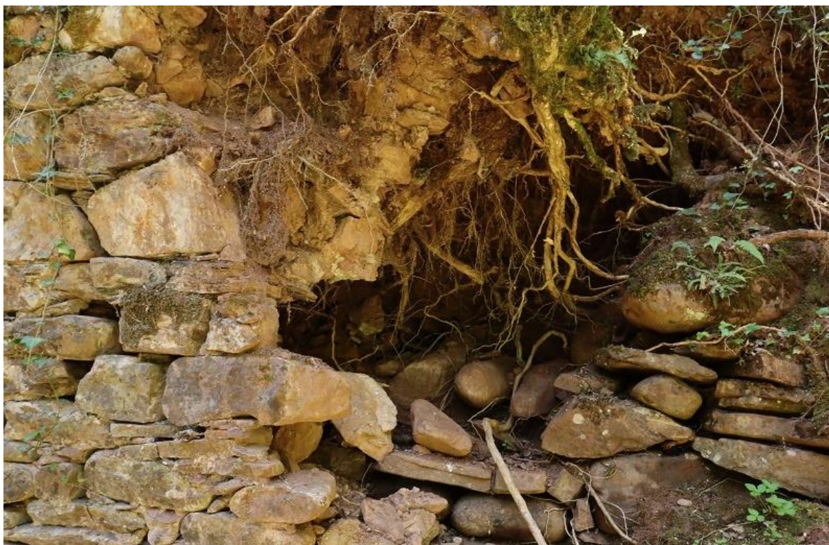
Imagen en la que se observa el relleno del interior del muro de la aleta.
