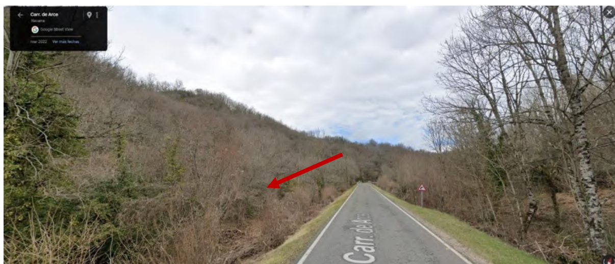
Localización del puente desde la carretera en dirección Burguete. Imagen del año 2022 extraída de Google Street View.
