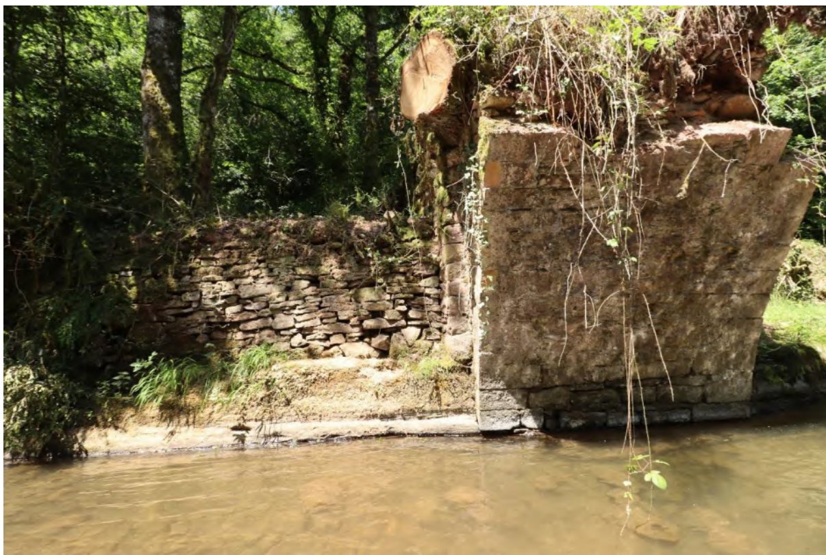
Muro de contención adosado al estribo aguas abajo de la margen derecha.
