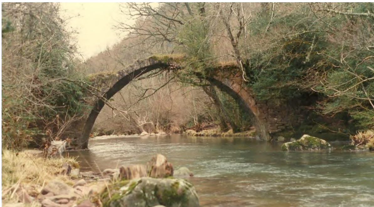
Imagen del puente antes del desplome del arco. Fotografía de fecha desconocida facilitada por el alcalde Javier Díez.
