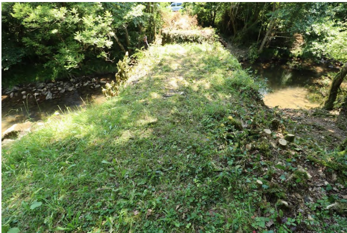
Fotografía de la parte superior de la margen derecha de los restos del puente donde se aprecia vegetación más tupida.
