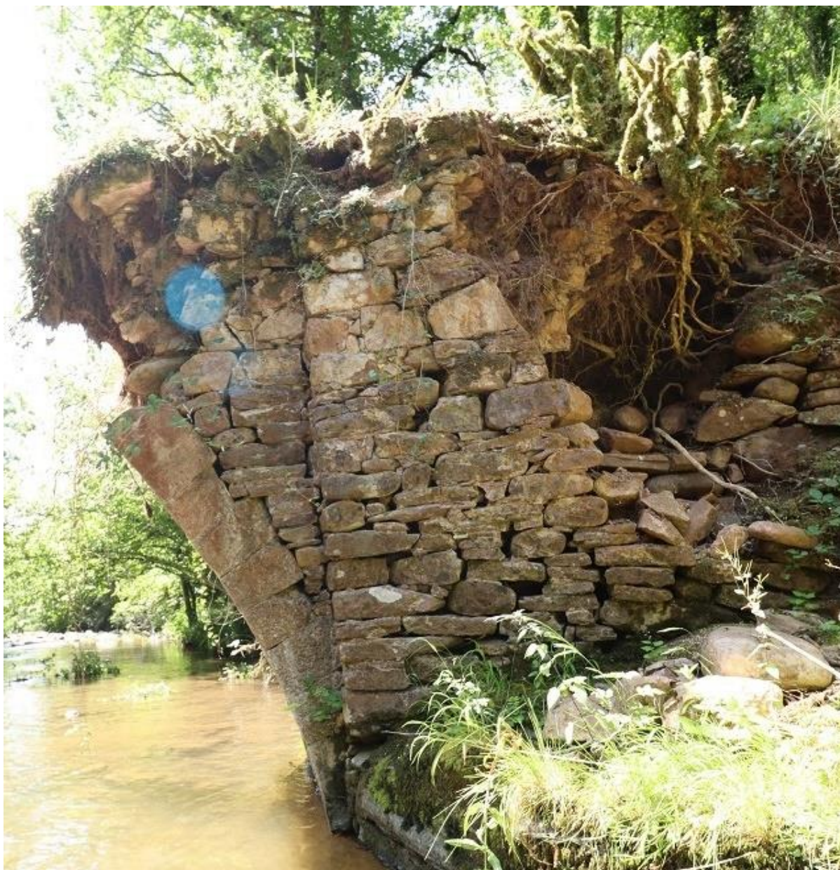
Diferentes tipos de piedra en la fábrica del puente.
