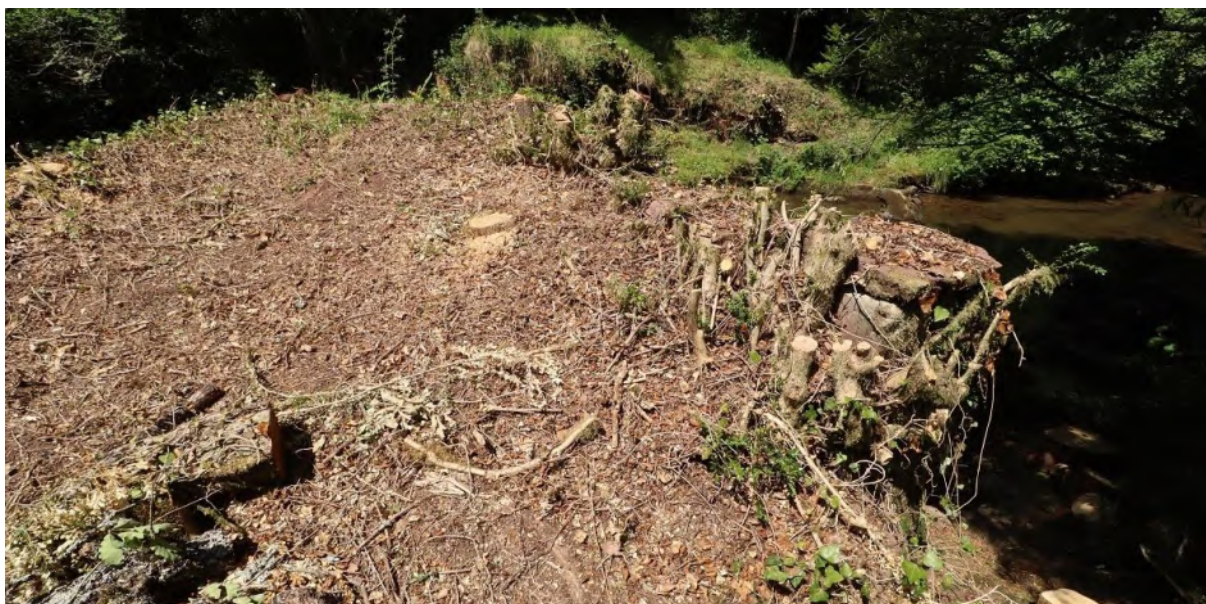
Fotografía de la parte superior de la margen izquierda de los restos del puente.
