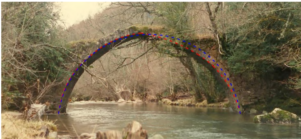
Fotografía del alzado del puente aguas arriba, cuando el arco seguía en pie. Geometría real grafiada en rojo, la teórica en azul.
