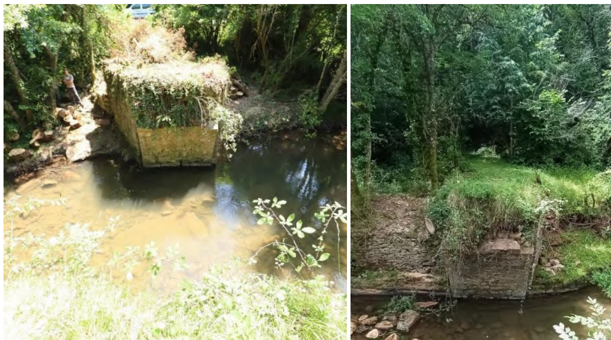
Imágenes de las dos orillas del río tomadas desde la parte superior de cada extremo del puente. Izquierda: margen izquierda. Derecha: margen derecha.
