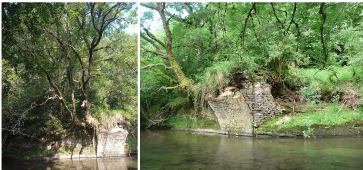
Fotografía de la margen derecha antes de la tala del roble arraigado en el estribo del puente.
