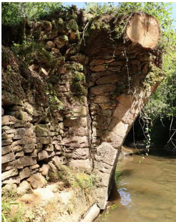
Fábrica de los tímpanos y estribos. Izquierda: margen derecha. Derecha: margen izquierda.
