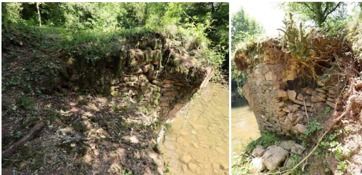
Fotografías de la parte superior de los muros de la parte del puente de la margen derecha.
