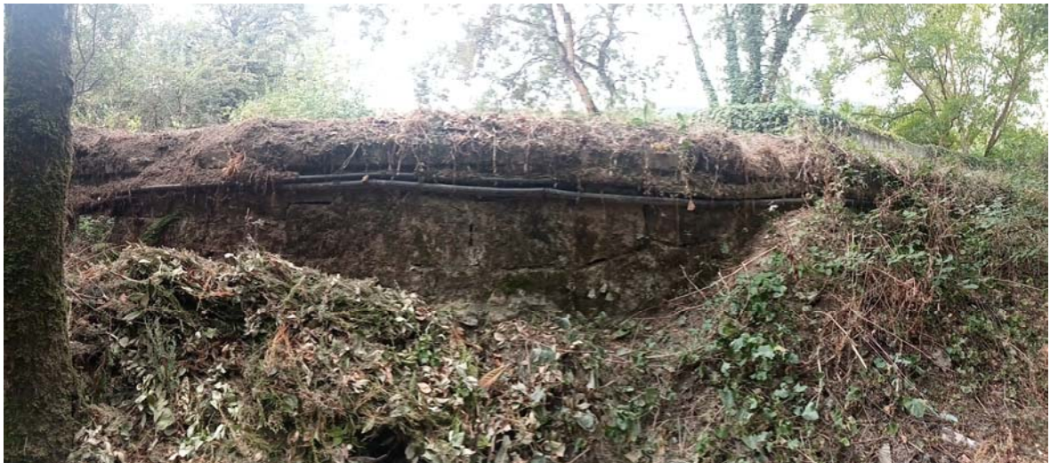
Muro en continuidad con estribo puente
