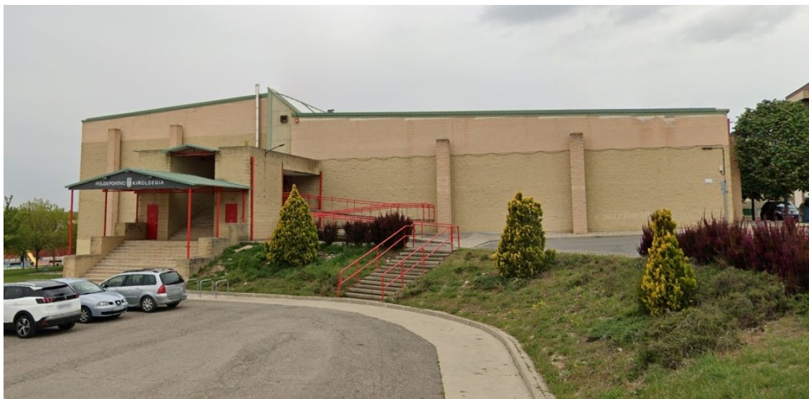
- vista de la fachada principal del polideportivo municipal -
