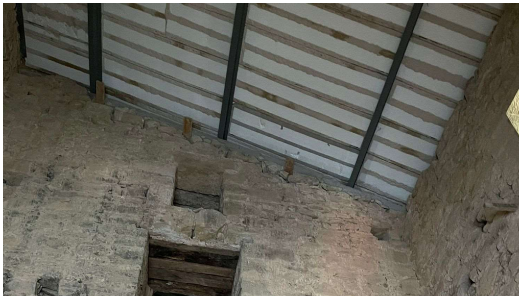
Imagenr: Estado actual de la cubierta de la sala, después de la intervención de finales del siglo XX.
