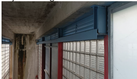
VIGA IPE 200 CORTADA Y SOLDADA A VIGA IPE 150 DE DESCUELQUE
