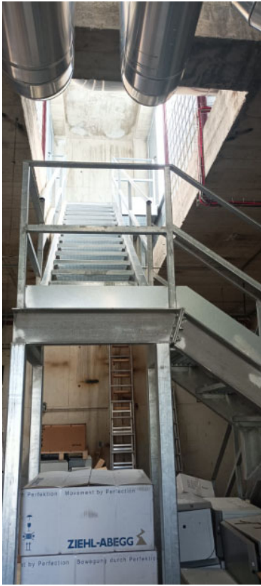
ESCALERA ACCESO ESPACIO CASETONES 1-
