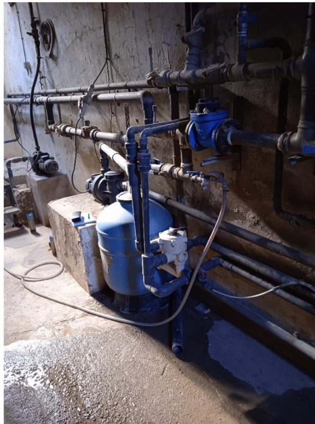
EQUIPOS FILTRACION PISCINA CHAPOTEO. PLANTA SOTANO
