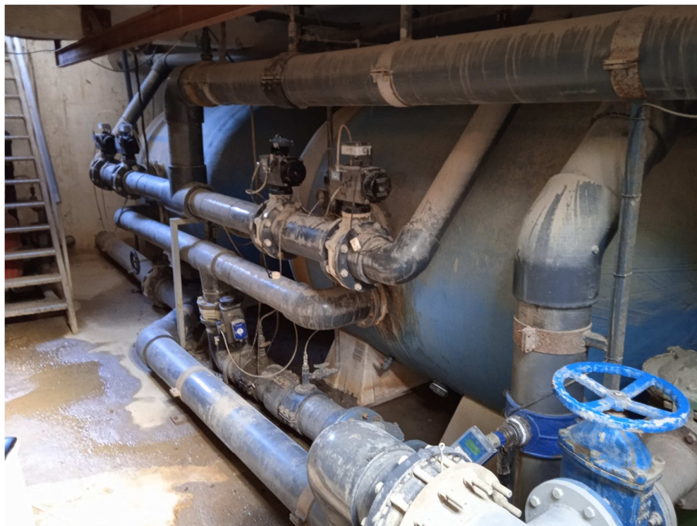
EQUIPOS FILTRACION PISCINA GRANDE. PLANTA SOTANO
