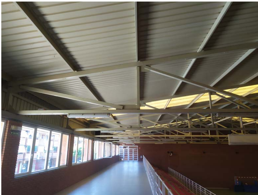
Fotos 03 y 04: Interior del pabellón polideportivo y zona superior a donde llegará el nuevo ascensor.
