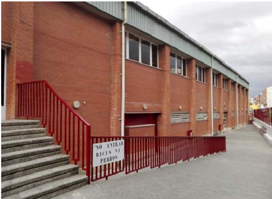
Foto 01: Fachada principal del polideportivo.
