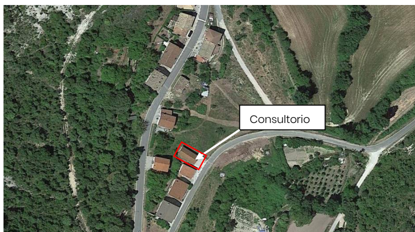
Foto nº 1: Emplazamiento del Consultorio
